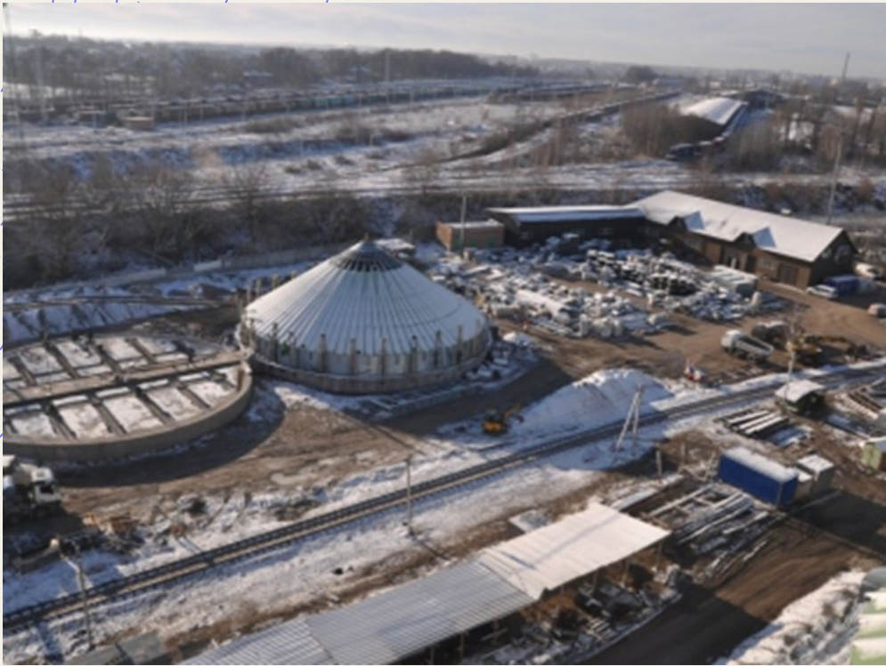
Рис. 4 Перша черга будівництва комплексу елеватору по вул. Зулінського, м. Вінниця.
