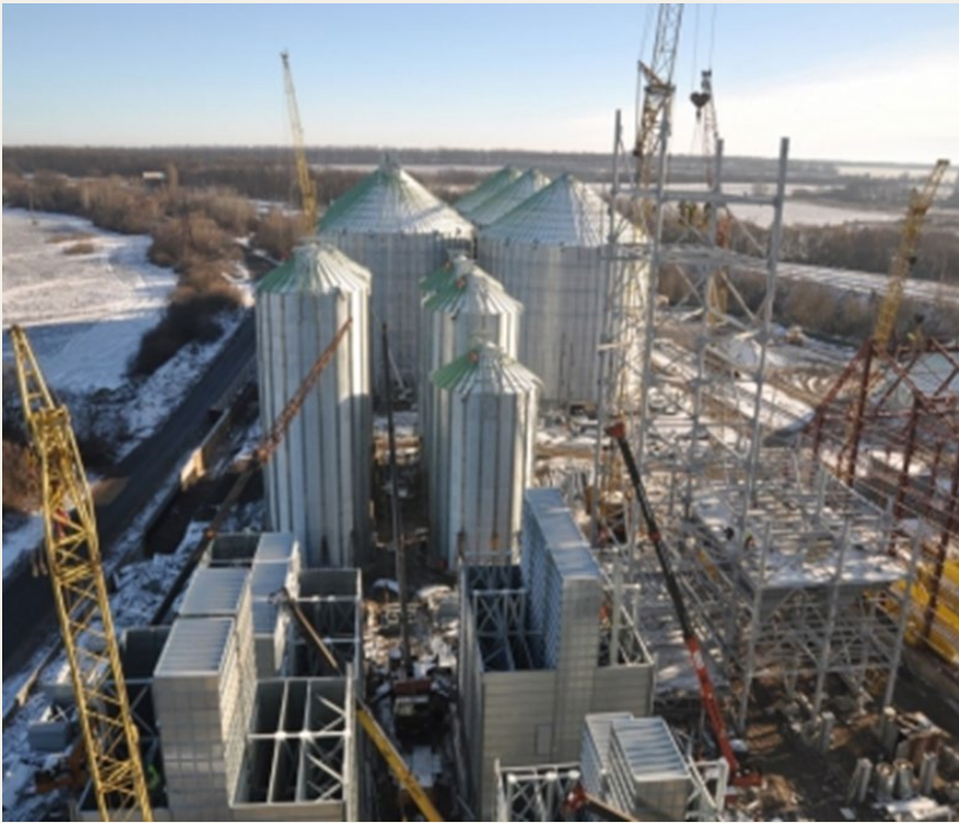
Фінальна стадія другої черги будівництва комплексу елеватору по вул. Зулінського, м. Вінниця, 2020 рік.
