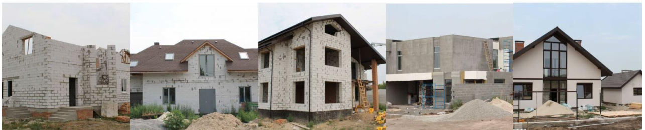
Рисунок 1.4 – Зведення індивідуальних малоповерхових будинків із газоблоків
