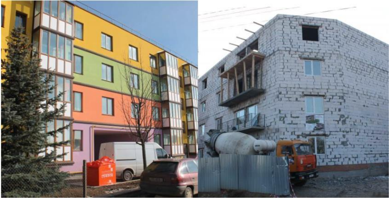
Рисунок 1.3 – Зведення багатоповерхових житлових будинків із використанням газоблоків
