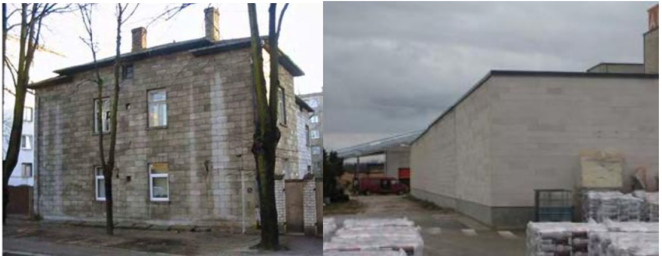
Рисунок 2.2 – Будівлі з автоклавного газобетону без зовнішнього оздоблення
