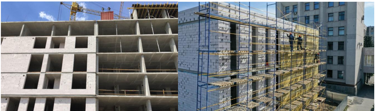
Рисунок 1.2 – Зведення громадської будівлі із використанням газоблоків
