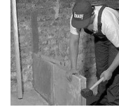
Рис. 5. Укладання плит першого ряду
