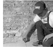
Рис. 3. На підлозі розміщують проектне положення перегородки
