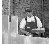
Рис. 6. Укладка плит "вразбіжку"
