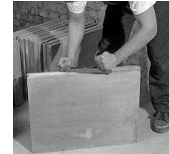
Рис. 5. Укладання плит першого ряду
