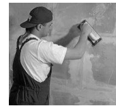
Рис. 11. Дороботка поверхні шліфуванням
