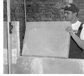
Рис. 6. Укладка плит "вразбіжку"
