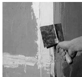
Рис. 9. Укріплення внутрішніх кутів за допомогою армуючої стрічки, приклеєної на шпаклівку
