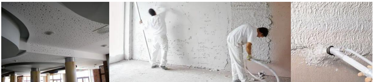
Рисунок 1.5 – Нанесення акустичних штукатурок
