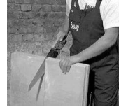
Рис. 7. Підрізка плит
