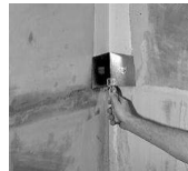
Рис. 10. Вирівнювання внутрішніх кутів
