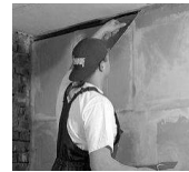
Рис. 8. Простину між стелею і плитою останнього ряду заповнюють шпаклівкою
