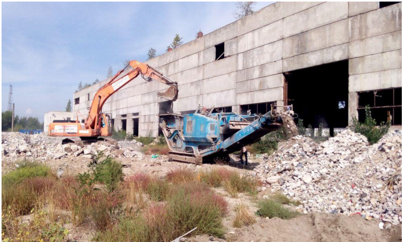
Рисунок 1.1 – Переробка демонтованих конструкцій будівлі в щебінь
