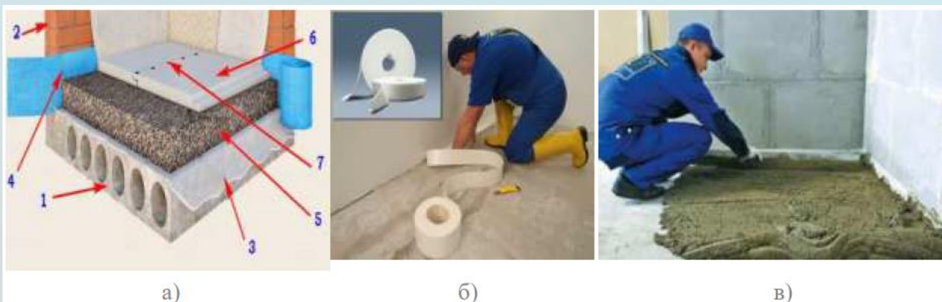
Рис. 4. Влаштування тепло-, звукоізоляційної стяжки на основі пінокераміки: а) конструктивно-технологічна схема підлоги, б) влаштування демпферної стрічки на основі спіненого поліетилену, в) влаштування тепло-, звукоізоляційної стяжки. 1-плита перекриття, 2-стіна, 3 - пароізоляція, 4 - демпферна стрічка, 5 - стяжка на основі гранул пінокераміки, 6,7 - підлогове покриття
