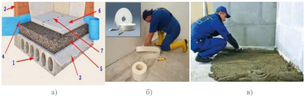
Рисунок 1.4 – Влаштування тепло-, звукоізоляційної стяжки: а) схема підлоги:
