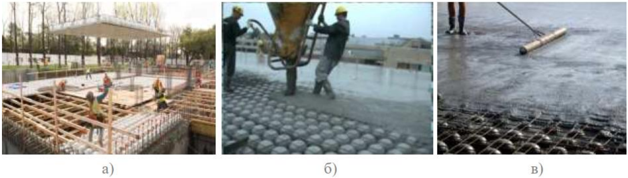
Рисунок 1.3 – Влаштування збірно-монолітних полегшених перекриттів: а) монтаж опалубки та конструкцій плит перекриття; б) укладання бетонної суміші; в) ущільнення та вирівнювання поверхні
