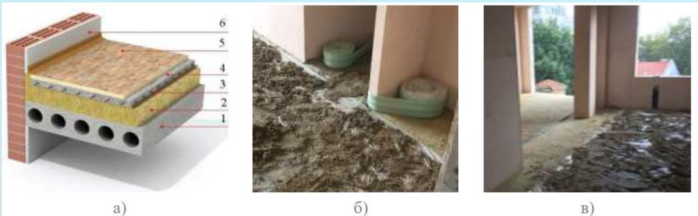
Рис. 5. Влаштування «плаваючої» підлоги на основі мінеральної вати по монолітному перекриттю в житловому будинку: а) конструктивно-технологічна схема, б) влаштування демпферної стрічки на основі спіненого поліетилену, в) влаштування мінеральної вати, шару гідроізоляції (поліетиленова плівка) та підготовки під цементно-піщану стяжку
