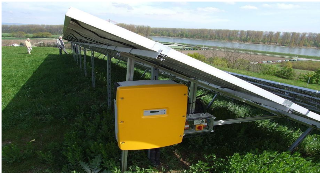
Рисунок 2.4 – Приклад автономного інвертора сонячних панелей
