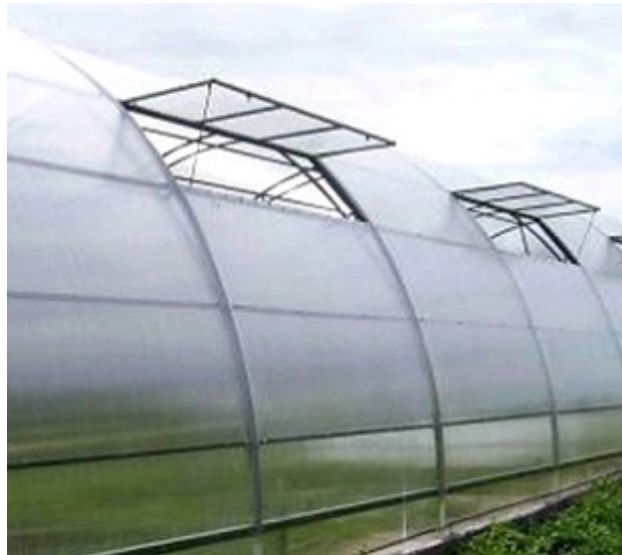
Рисунок 1.2 – Природна вентиляція промислової теплиці
