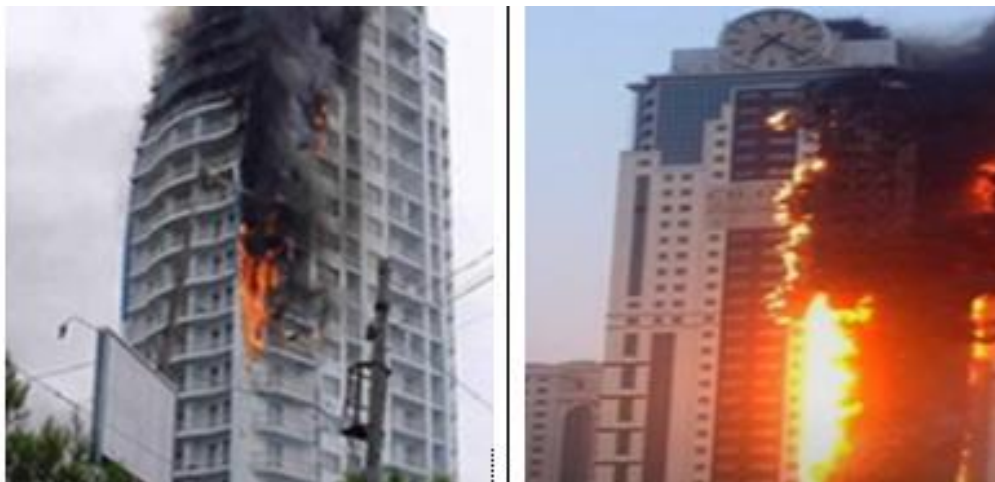
Риунок 4.7 Фрагмен горіння пінополістиролу на фасадах висотних будинків.
