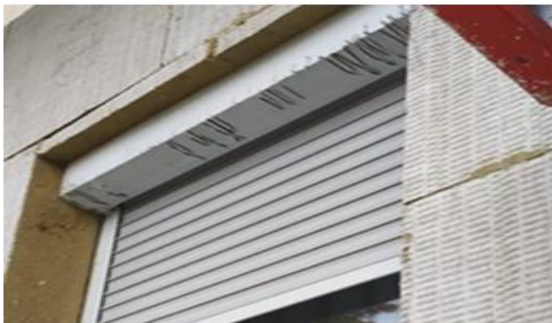
Рисунок 5.3 Фрагмент монтажу енергоефективних вікон та роlet.
