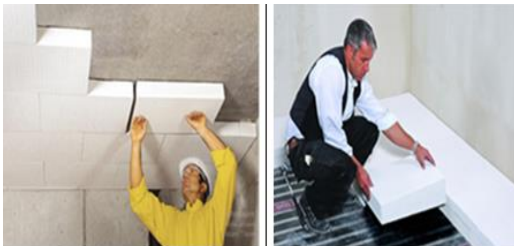
Рисунок 4.5 Схема внутрішнього утеплення підлоги та покрівлі.
