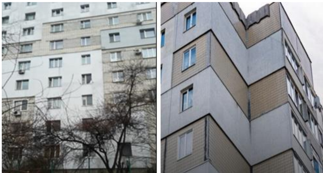
Рисунок 4.3 Зовнішній вигляд клаптикового утеплення фасадів будинків.
