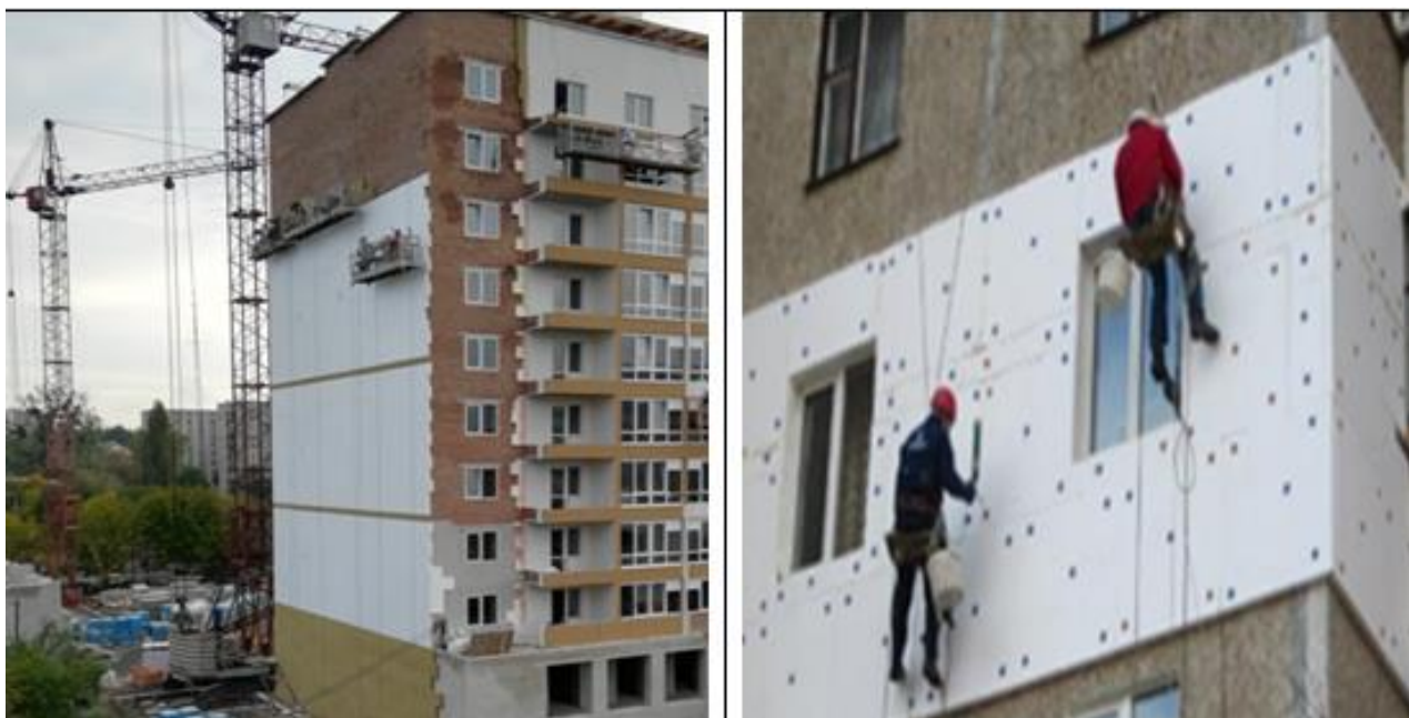
Рисунок 4.3 Утеплення фасадів з використанням монтажних люльок та альпіністів.
