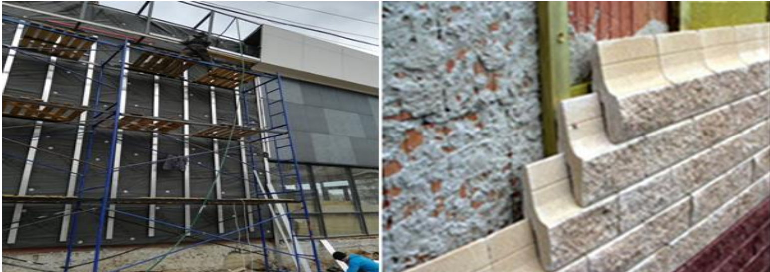
Зовнішній вигляд клямерів для фіксації облицювальних панелей
