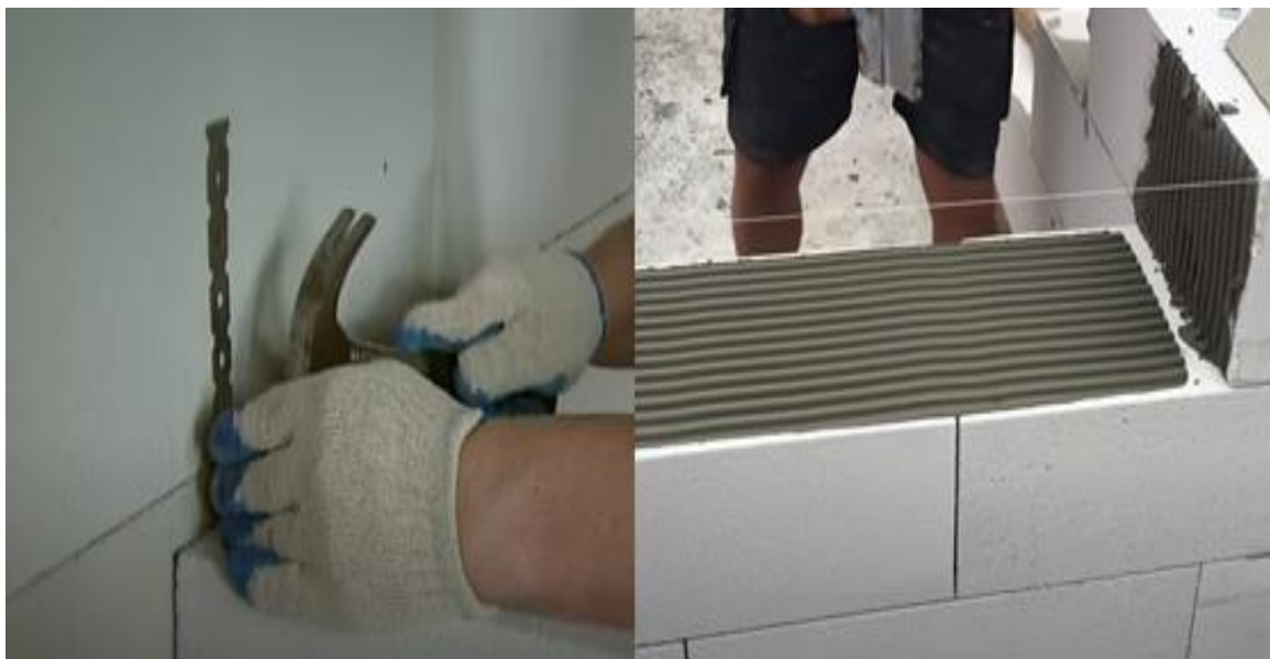
Рисунок 3.4 Підготовка першого ряду кладки газобетонних стін для виконання кладки.
