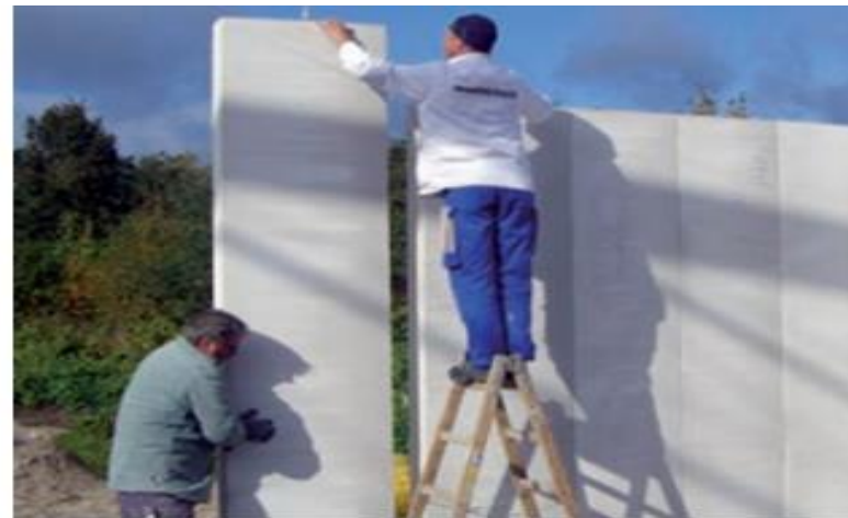
Вертикальні стінові панелі які швидко і легко монтуються
