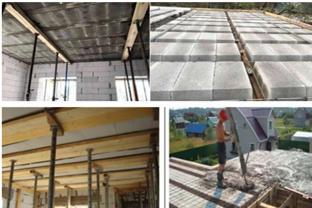
Рисунок 4.4 Фрагменти влаштування збірно-монолітного перекриття з використанням U-блоків.
