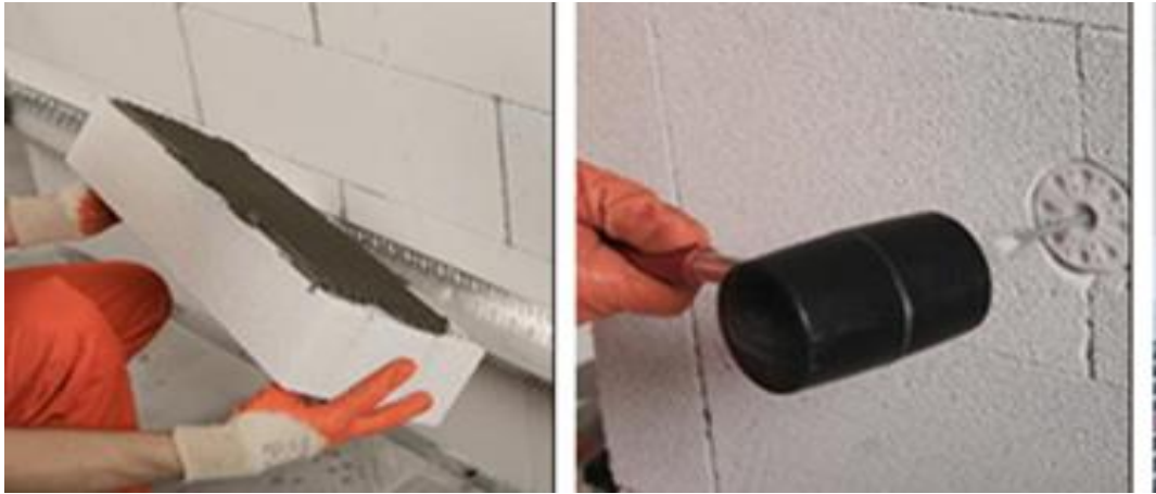
Рисунок. 3.15 Фрагмент зовнішнього утеплення стін будинку газобетонними плитами.
