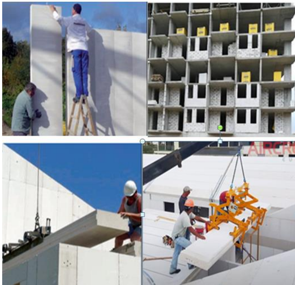
Рисунок 1.8 Фрагмент монтажу збірних газобетонних конструкцій.
