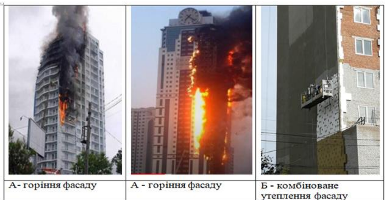
Рисунок 2.7 – Фрагменти пожежі високого будинку утепленого пінополістиролом, мінеральною ватою
