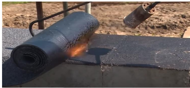
Рисунок 3.2 Фрагмент влаштування гідроізоляції на поверхні стрічкового фундаменту.
