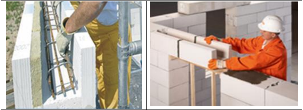
Рисунок 2.7 – Фрагменти влаштування віконної перемички з використанням U-блоків.
