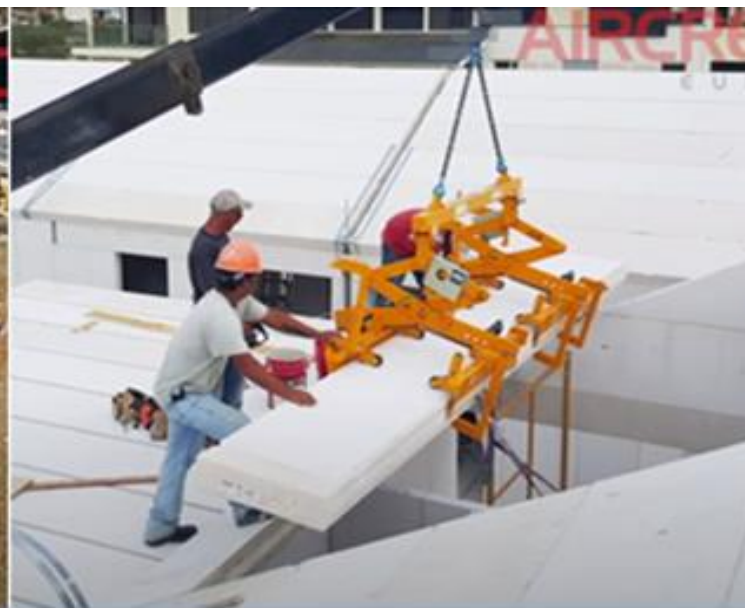
Вертикальні стінові панелі які швидко і легко монтуються
