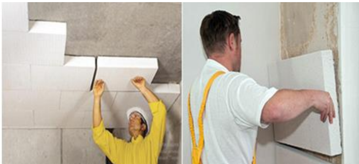
Рисунок 3.16. Внутрішнє утеплення стін і стелі газобетонними плитами.
