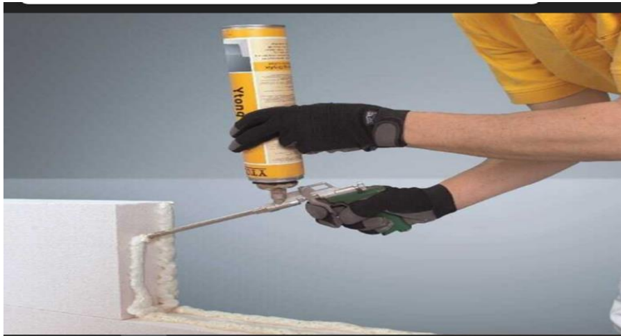
Рисунок 3.6 Фрагмент кладки внутрішні перегородок з газобетонних блоків з використанням пінополіуретанового клею.
