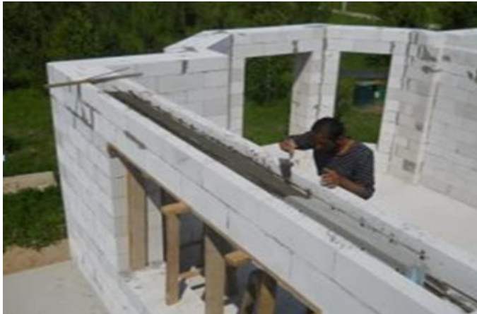
Рисунок. 2.8 – Зовнішній вигляд фасаду будівлі з використанням U-блоків.
