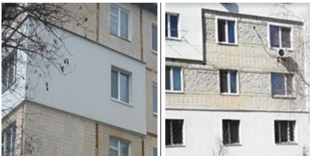
Рисунок 1.4 Зовнішній вигляд «кляптикового» утепленого фасаду будинку. (м. Вінниця, 2024р)
