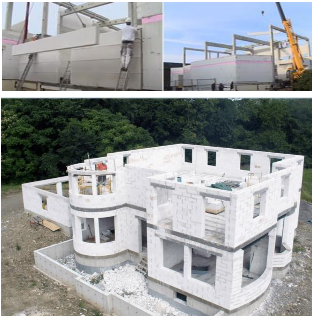
Рисунок 4.2 Схема будівництва промислових і житлових об'єктів з використанням газобетонних виробів.
