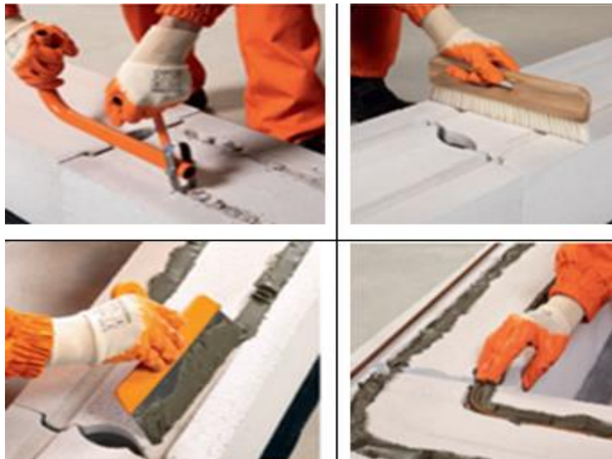
Рисунок 3.7. Технологічна послідовність влаштування армованого поясу стіни.
