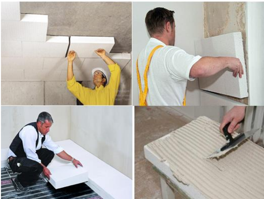
Рис. 4.1- Використання теплоізоляційних блоків з автоклавного газобетона для утеплення стін, покрівлі, підлоги [23].
