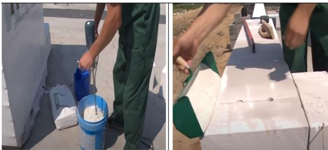
Рисунок 3.5 Приготування клесної суміші та нанесення її з використанням спеціального ковша.
