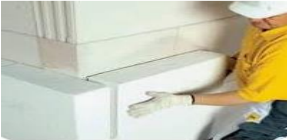
Рис. 2.4 Утеплення фасаду газобетонними плитами «Multipor»
