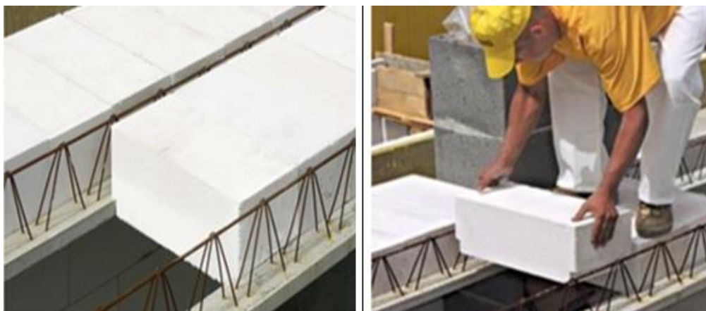
Рисунок 4.3 Фрагмент використання Т-блоків при влаштуванні перекриття
