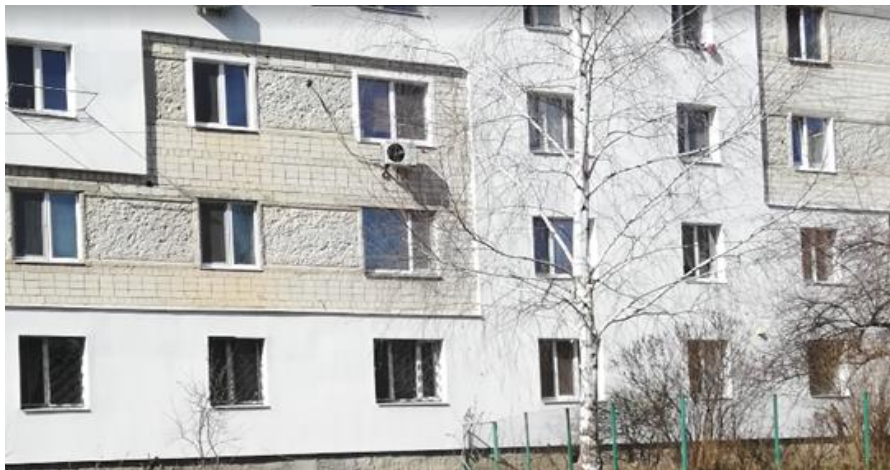
Рисунок 3.4 Фрагмент фасаду клаптикового утеплення стіни.
