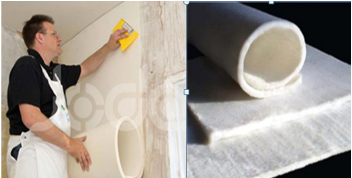
Рис. 4.2 Фрагмент утеплення стіни аерогелем.
