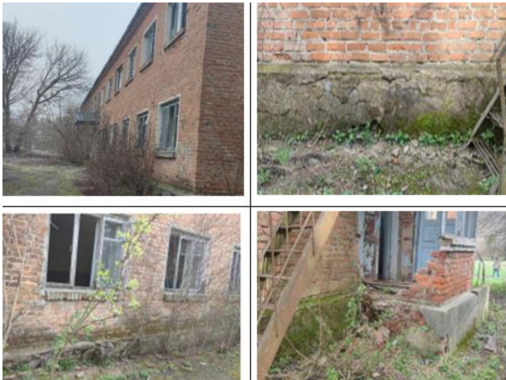
Рисунок 5.1 Зовнішній вигляд будівлі до термомодернізації
