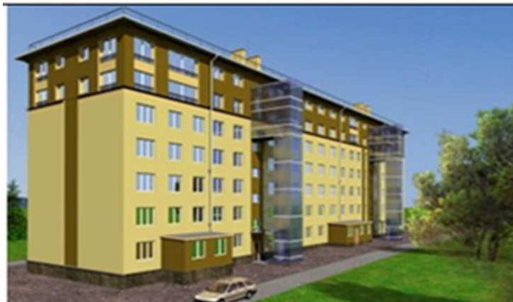
Рисунок 2.3. Утеплення та надбудови будинків з отриманням додаткової житлової площі.
