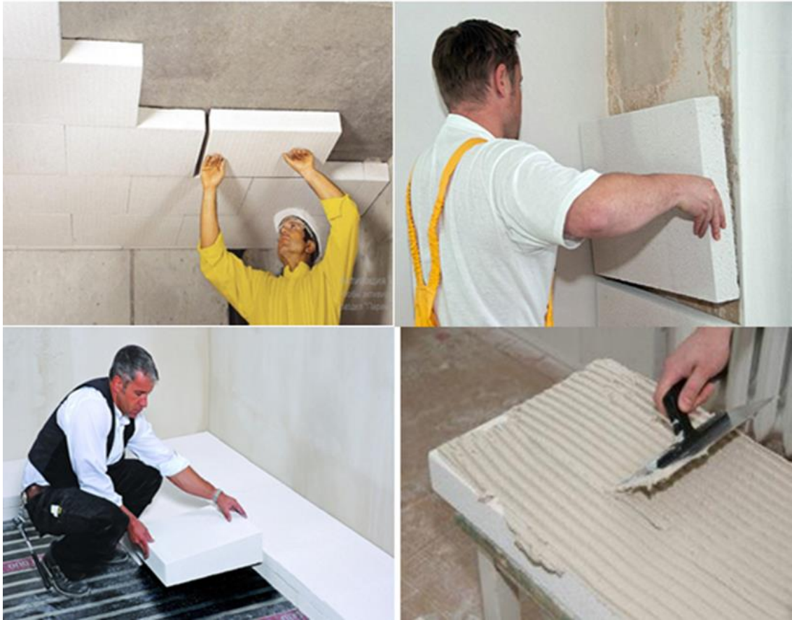
Рисунок 3.1 Фрагменти внутрішнього утеплення стін, пілоги, перекриття
