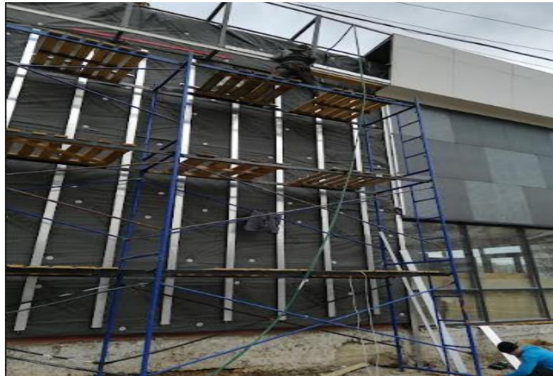
Рисунок 3.7 Фрагмент вентильованого фасаду з використанням алюмінію.
