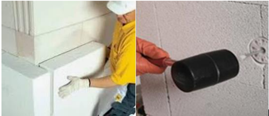
Рисунок 3.2 Утеплення фасаду газобетонними плитами «Multipor»
