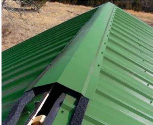
Рисунок 3.8 – Облаштування гребеневого вузла з поролоновим ущільнювачем
