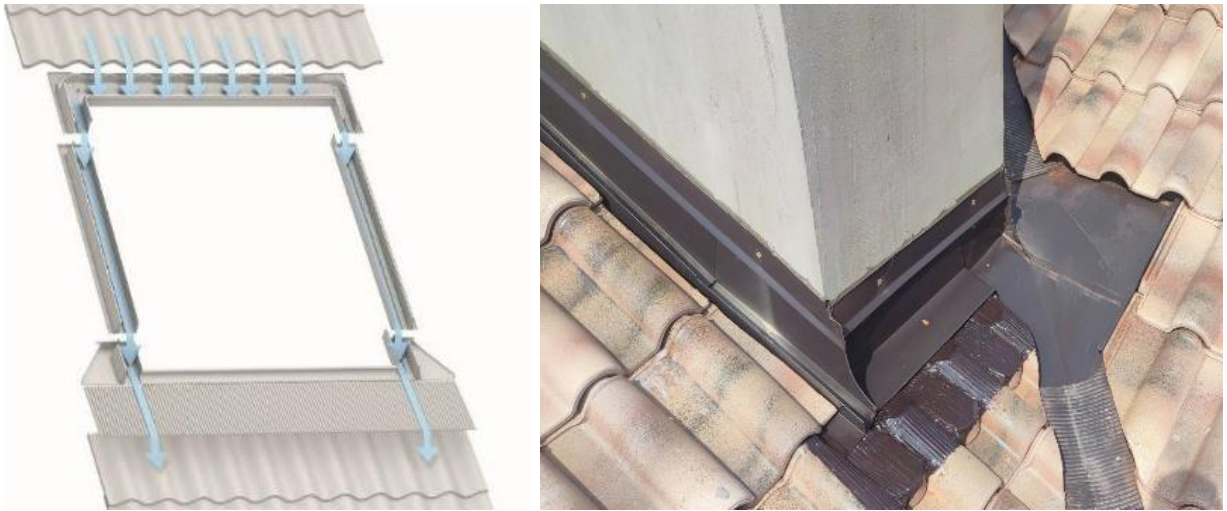
Рисунок 3.5 – Вигляд удосконаленого фартуха пічної труби
