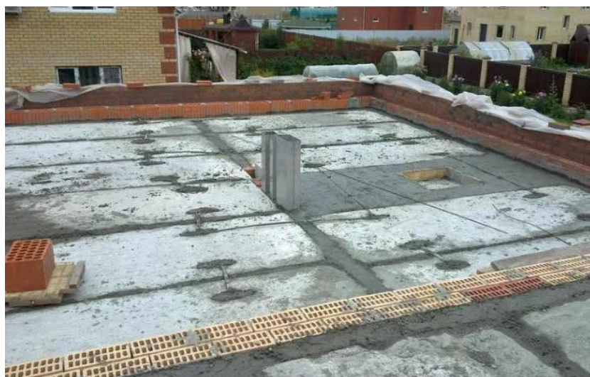
Рисунок 4.7 – Перекриття із закладеними швами
