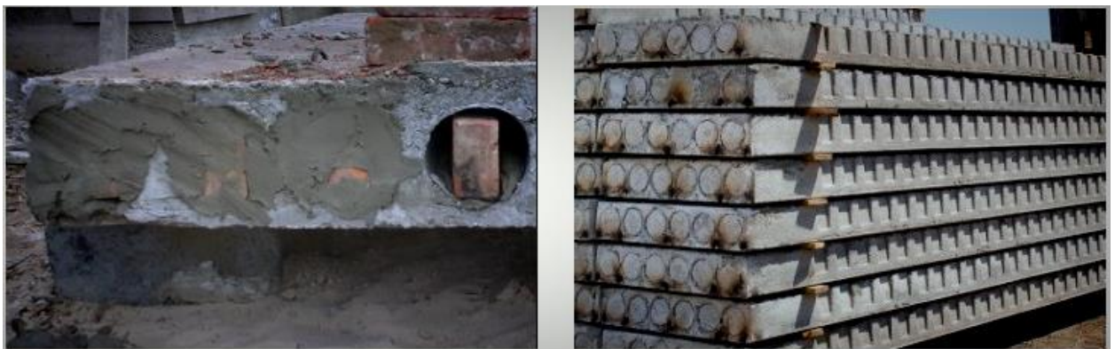
Рисунок 4.3 – Закладання отворів в торцях плит перекриття перед монтажем
