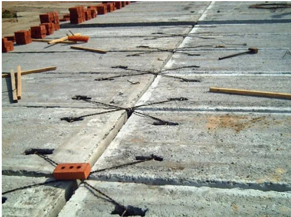
Рисунок 4.5 – Анкерування плит перекриття
