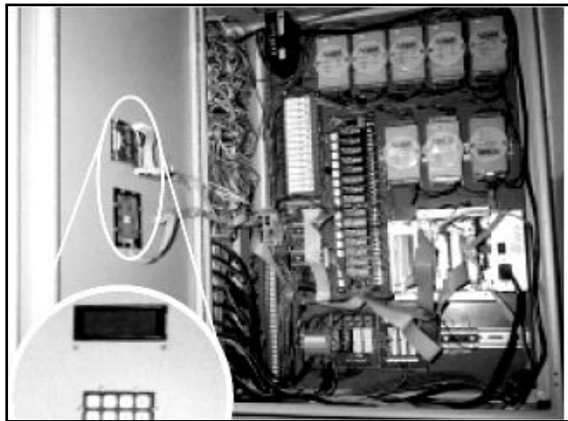
Рисунок 1.4 – Монтаж контролера тензовимірювального
