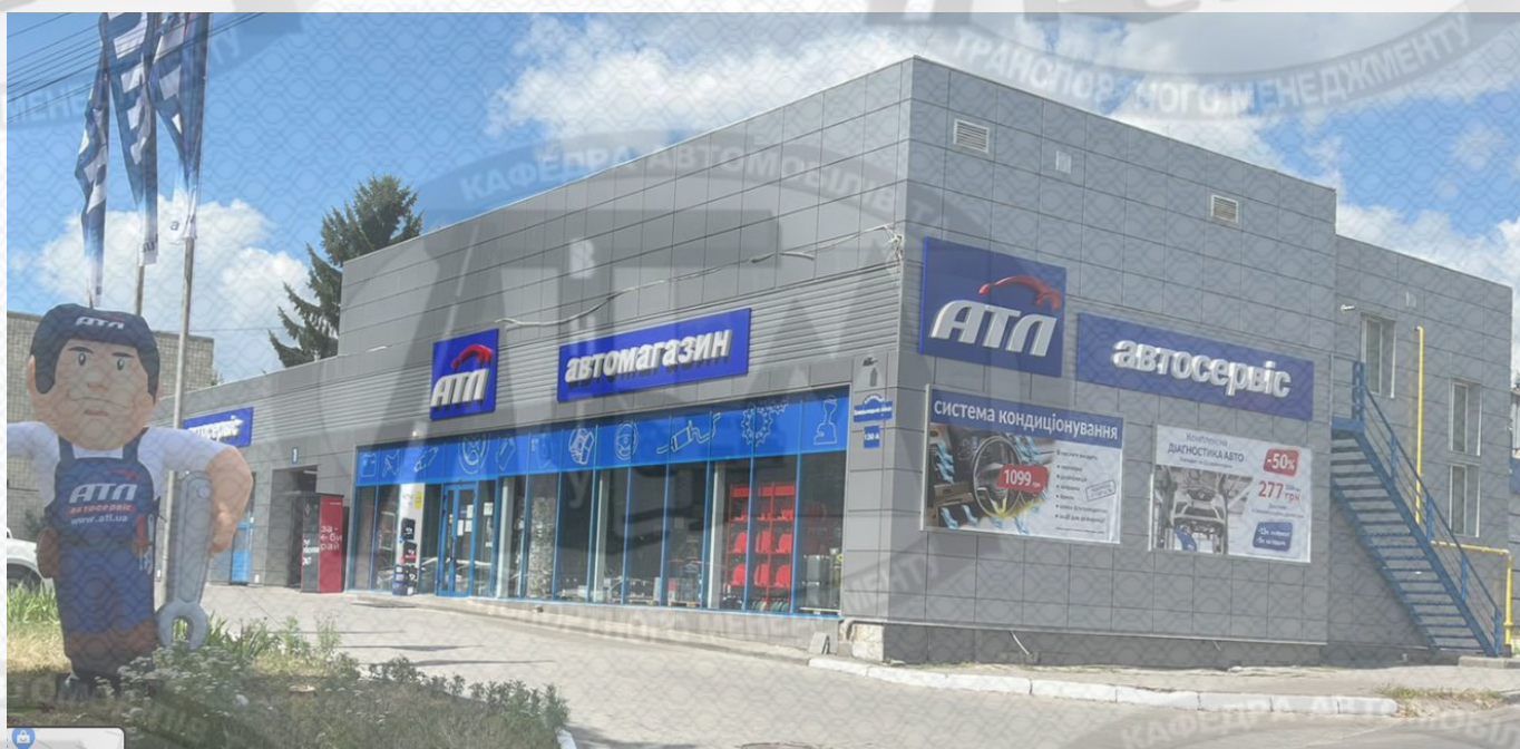
Рисунок 1.1 – Станція технічного обслуговування автомобілів «АТЛ» м. Вінниця
