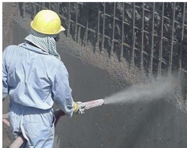
Рис. 1.1 – Торкретування підсилювальної поверхні
