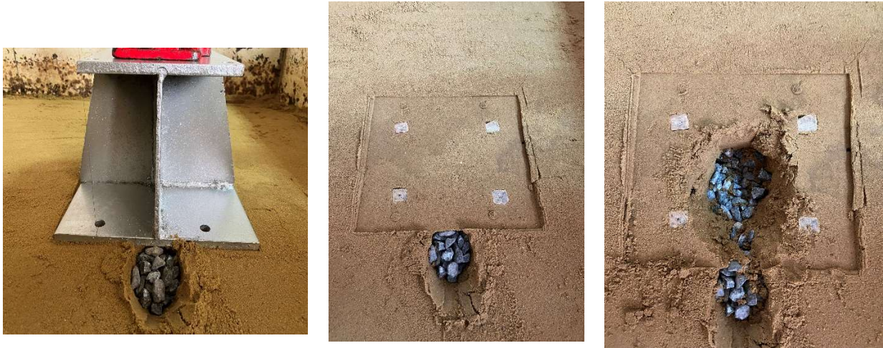
Рис. 2.8 – Контроль підсиленої ґрунтової основи
