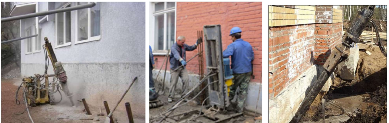
Рис. 4.3 – Буріння свердловин для безпідвальних будівель
