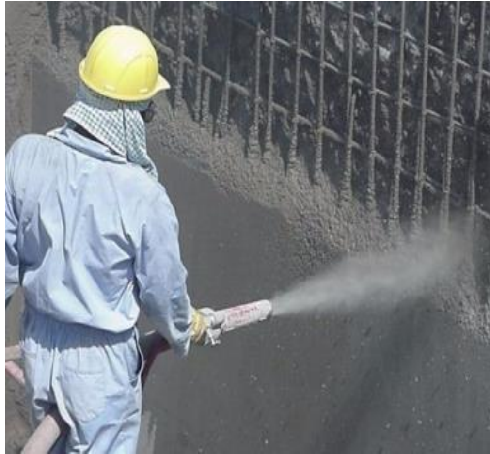
Торкретування підсилувальної поверхні
