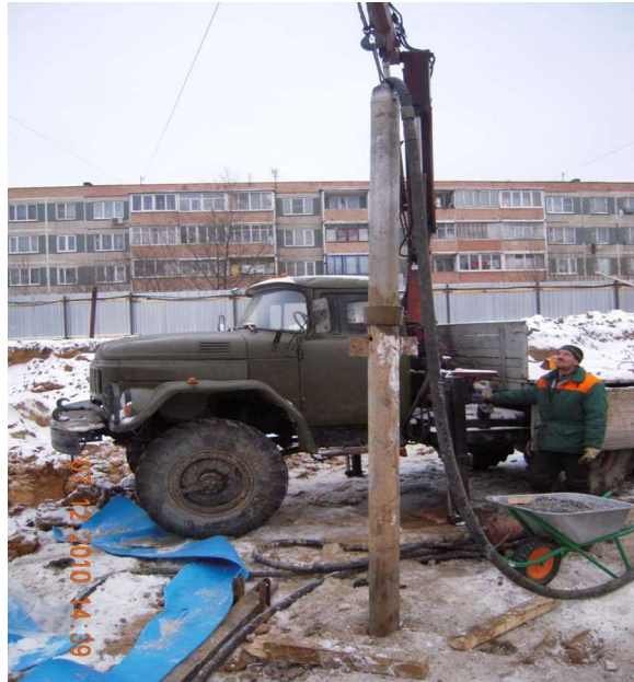
Рис. 1.9 – Виконання робіт з щебених елементів з обсадної трубою
