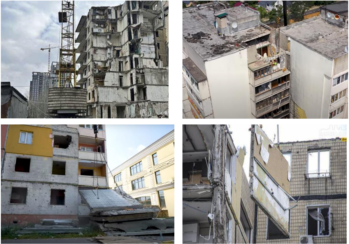
Рис. 1.8 - Демонтаж багатоповерхового будинку в Дніпрі
