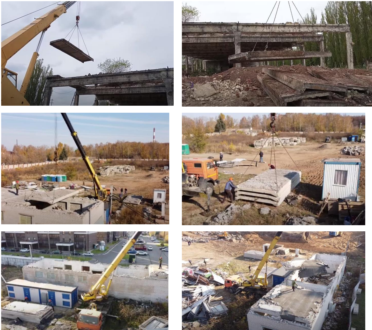
Рис. 1.12 - Демонтаж плит покриття
