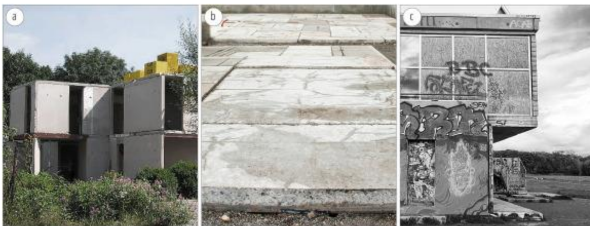
Рис. 1.3 - Рівні повторного використання бетону: приклад еквівалентного повторного використання плит у малоповерховому будівництві (а), повторного використання як дорожніх плит (b) та повторного використання в якості основ (c) [20].
