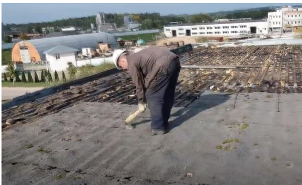
Рис. 11.5 - Демонтаж покрівель панельних і каркасних будівель
