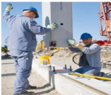
Рис. 1.19 – Збірно-розбірний залізобетонний каркас
