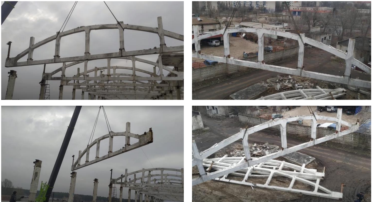
Рис. 1.11 - Демонтаж ферм одноповерхового промислового будинку
