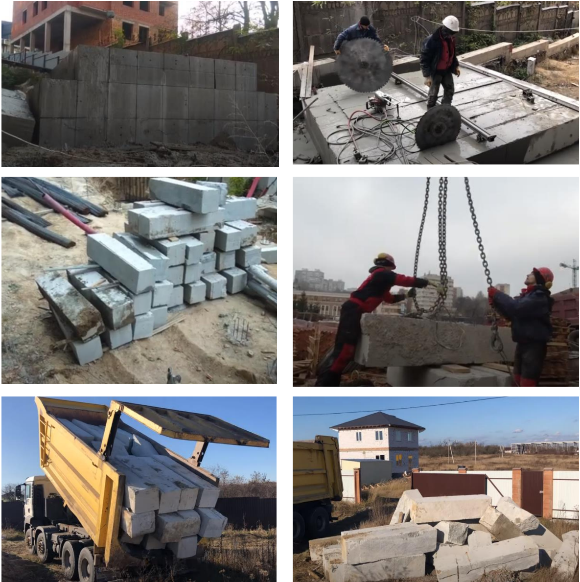
Рис. 1.18 - Демонтаж масивних залізобетонних конструкцій
