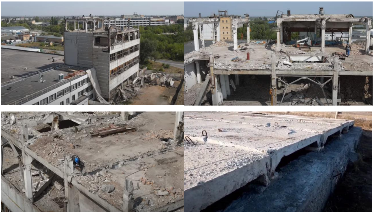
Рис. 1.13 - Демонтаж багатоповерхового промислового будинку
