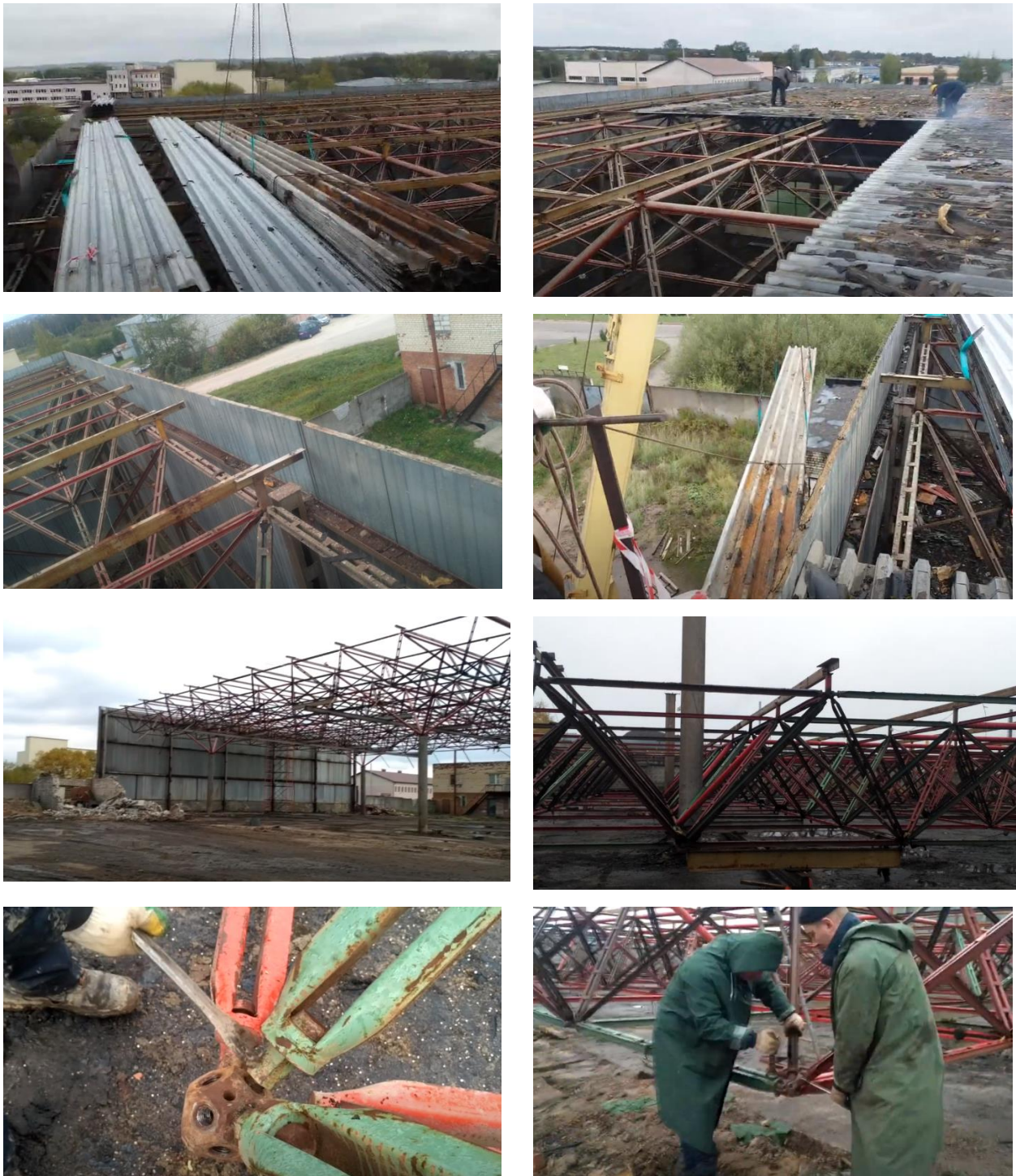
Рис. 1.10 - Демонтаж промислового будинку з металокаркасних конструкцій
