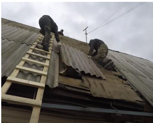
Рис. 1.14 - Демонтаж скатних дахів будівель з цегляними стінами
