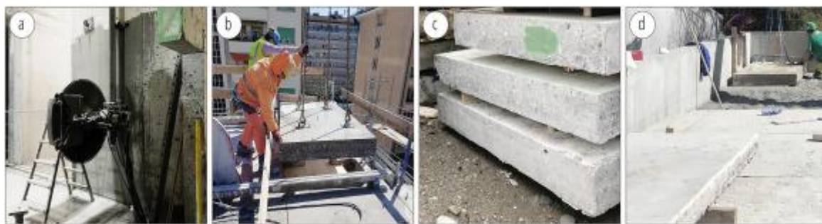
Рис. 1.2 - Процес повторного використання конструкцій: демонтаж (a,b), підготовка, зберігання (c) та повторне збирання (d) у новому проекті. Автори зображення: (a, c, d): FAZ Architectes; (б): Ingeni SA.
