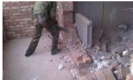
Рис. 1.6 - Демонтаж будівель з цегляними стінами
