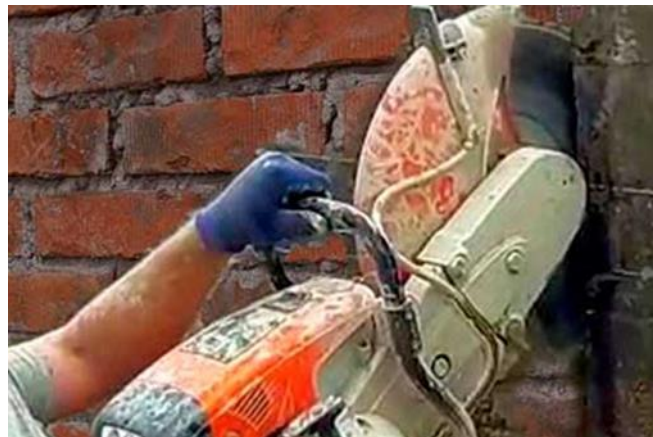
Рис. 1.17 - Демонтаж цегляних стін будівель
