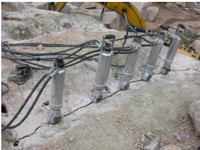
Рис. 1.25 – Руйнування бетону гідророзколюванням
