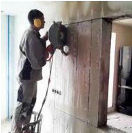
Рис. 1.17 - Демонтаж цегляних стін будівель
