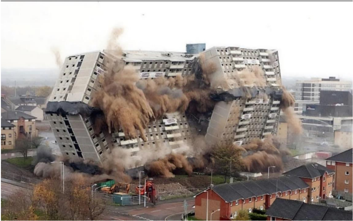
Рис. 1.20 – Вибуховий метод знесення
