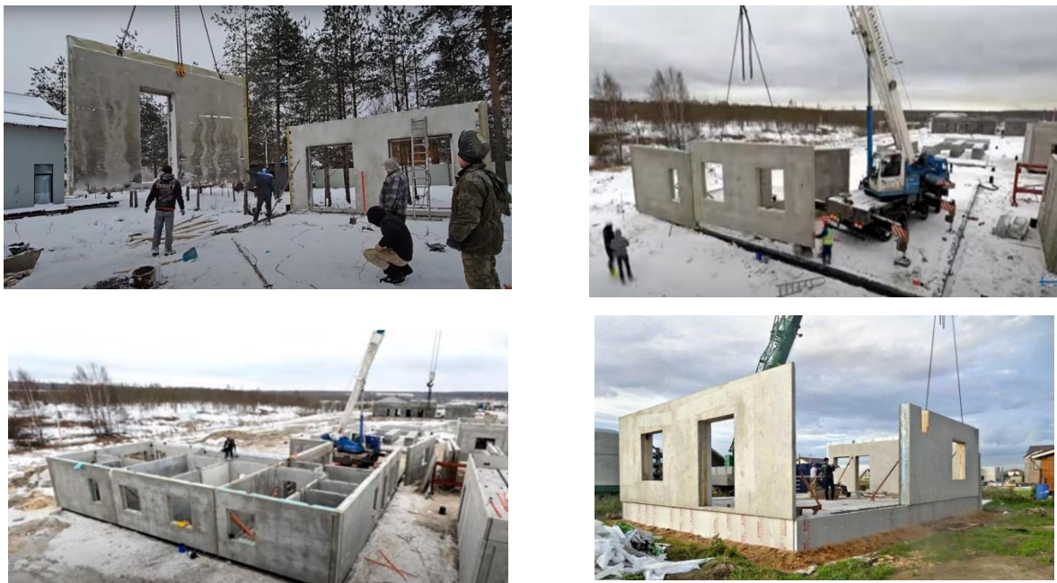
Рис. 27 – Будівництво приватного будинку з демонтованих панелей
