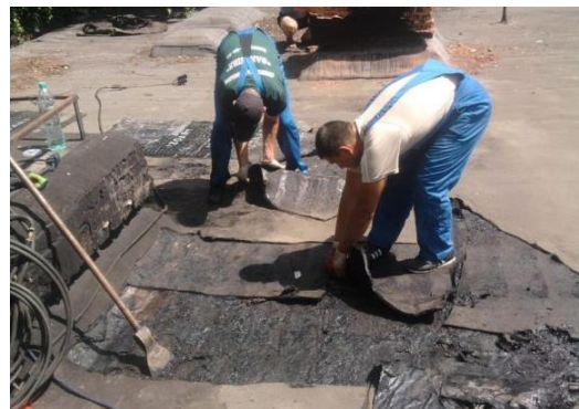
Рис. 11.5 - Демонтаж покрівель панельних і каркасних будівель
