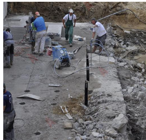
Рис. 1.25 – Руйнування бетону гідророзколюванням
