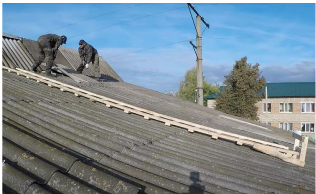
Рис. 1.14 - Демонтаж скатних дахів будівель з цегляними стінами
