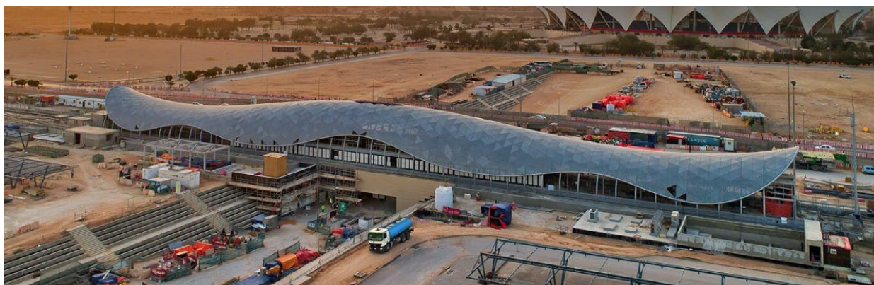
Рисунок 1.3 – Станція метро в Ер-Ріад
