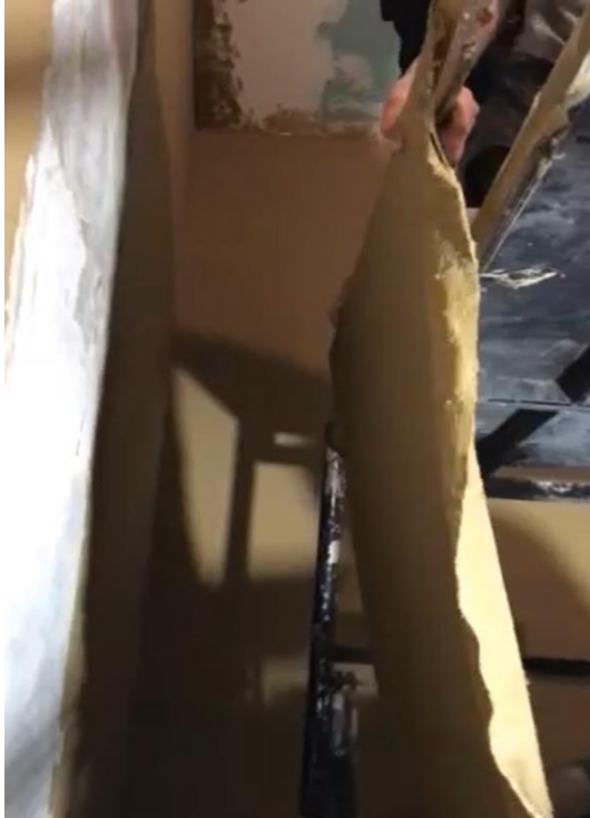
Рис. 2.4 – Підйом сітки з розчином до рівня стелі
