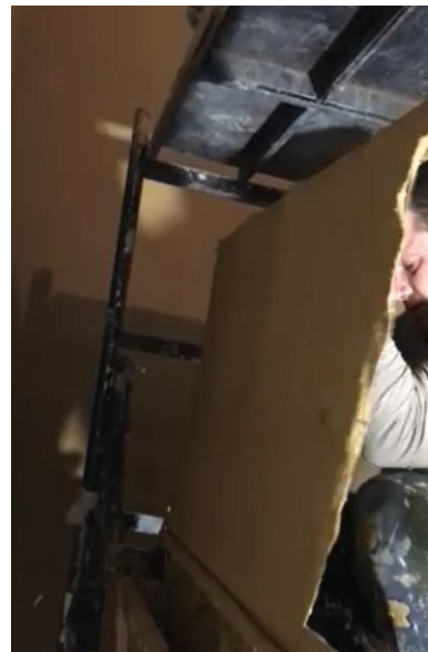
Рис. 2.3 – Насичення армуючої сітки глиняним розчином
