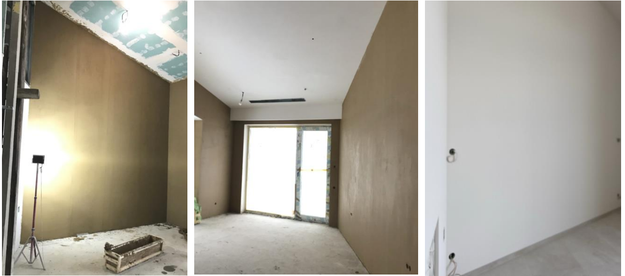
Рис. 2.8 – Фінішна обробка штукатурного шару
