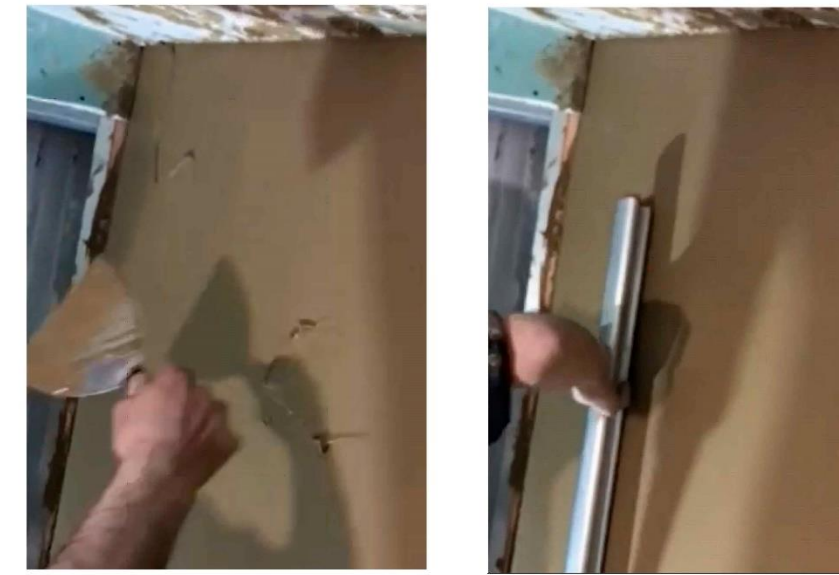
РОЗРІВНЮВАННЯ ДВЕРНИХ ТА ВІКОННИХ ВІДКОСІВ
