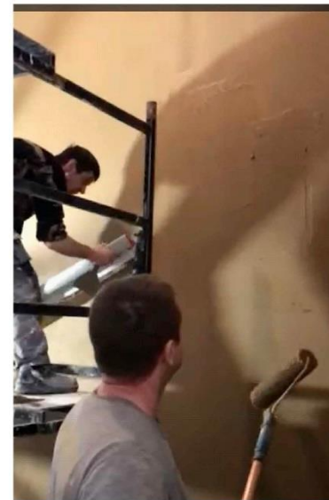
РОЗРІВНЮВАННЯ ШТУКАТУРНОГО РОЗЧИНУ
