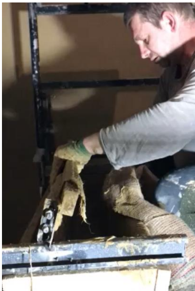
Рис. 2.3 – Насичення армуючої сітки глиняним розчином
