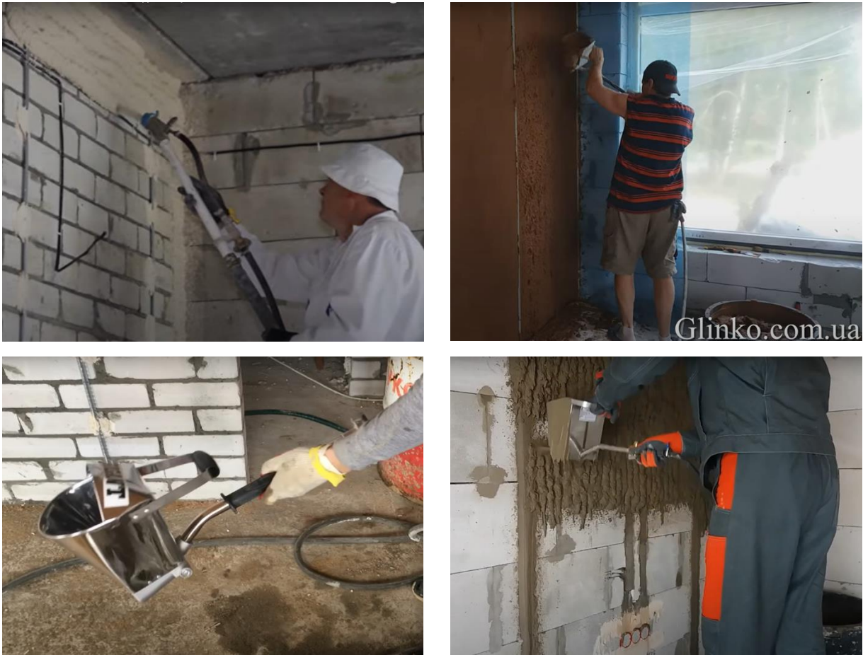
Рис. 1.2 – Механізми для нанесення штукатурного розчину на стіну
