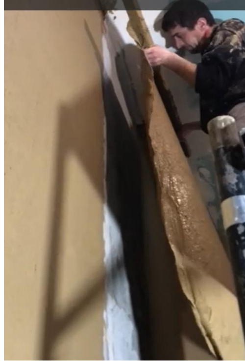
Рис. 2.4 – Підйом сітки з розчином до рівня стелі
