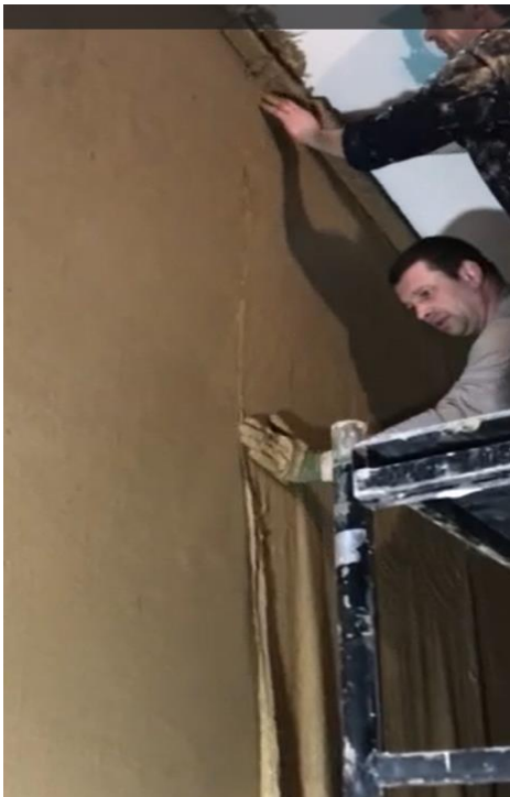
Рис. 2.5 – Розрівнювання і розглажування сітки на поверхні
