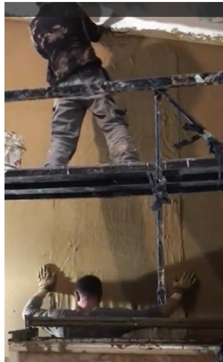
Рис. 2.5 – Розрівнювання і розглажування сітки на поверхні
