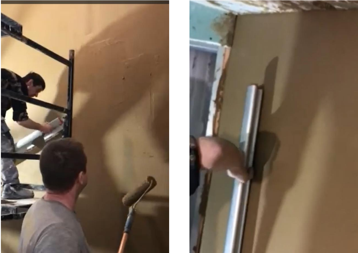
Рис. 2.6 – Вирівнювання поверхні штукатурного шару
