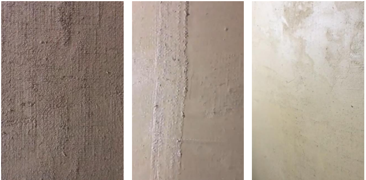
Рис. 2.7 – Поверхня штукатурного шару в процесі робіт
