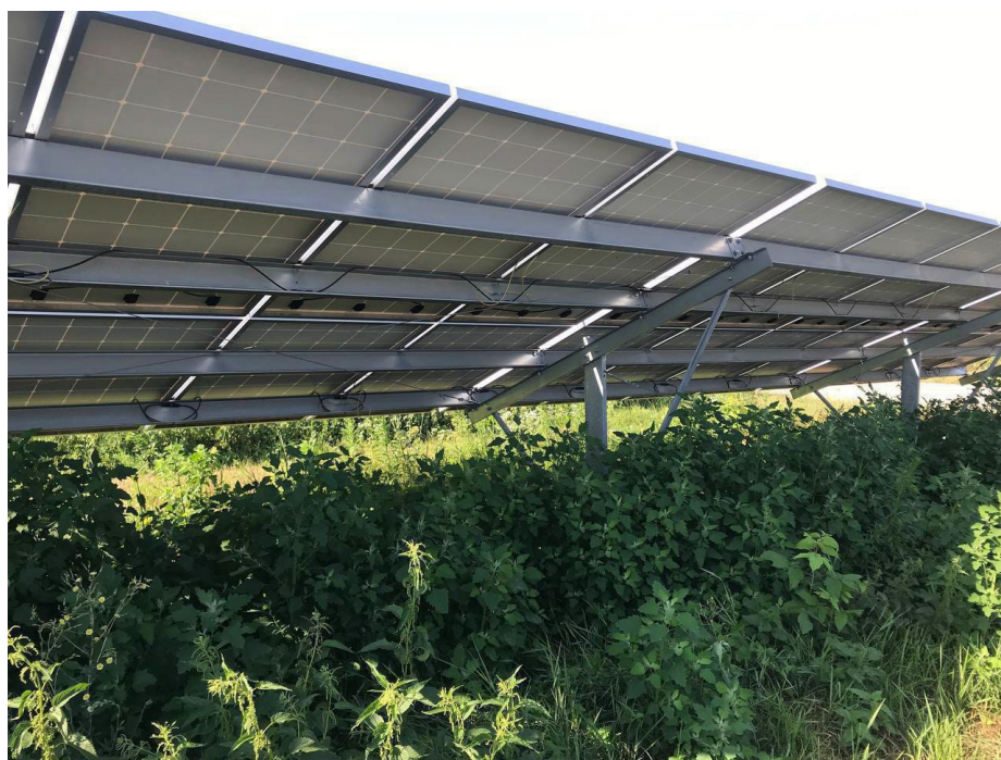
Рисунок 2.1 – Зовнішній вигляд існуючої конструкції
