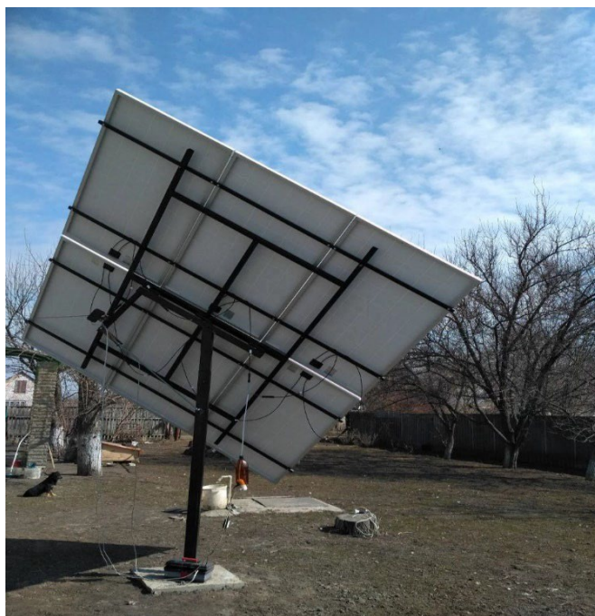
Рисунок 1.10 – Зовнішній вигляд трекера моделі ST1500
