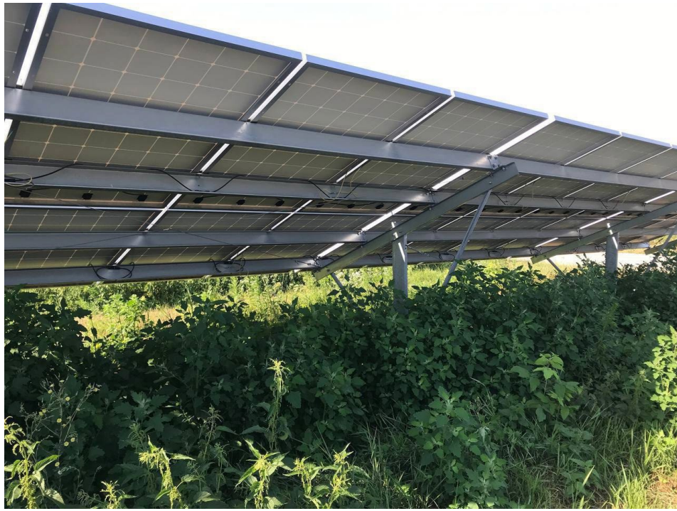
Рисунок 1.5 – Зовнішній вигляд кріплення панелей
