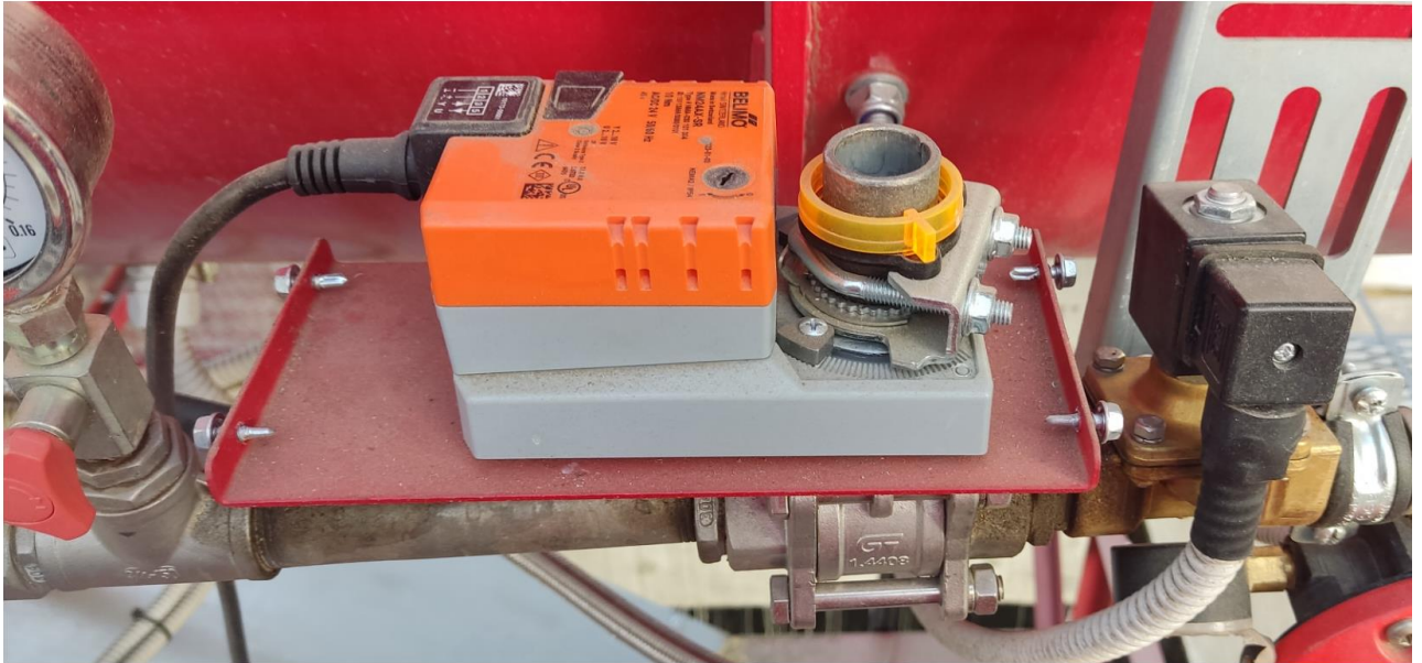
Рисунок 4.2 – Регуляторна група (регулятор тиску, електрична клапани, сервопривод крана подачі газу)
