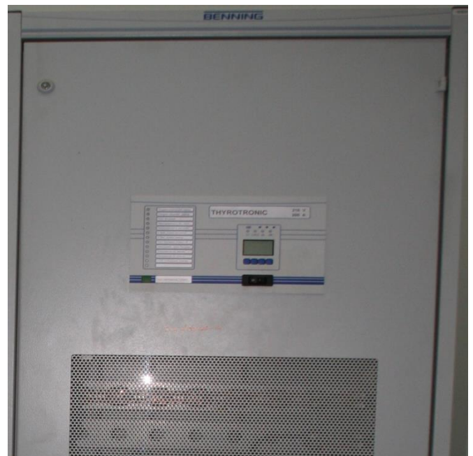
Рисунок 1.5 – Випрямний зарядно-підзарядний агрегат BENNING D400 G216/200
