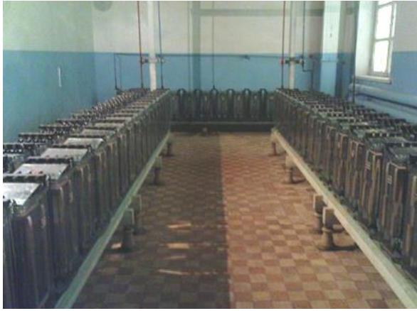
Рисунок 1.2 – Акумуляторна батарея типу СК
