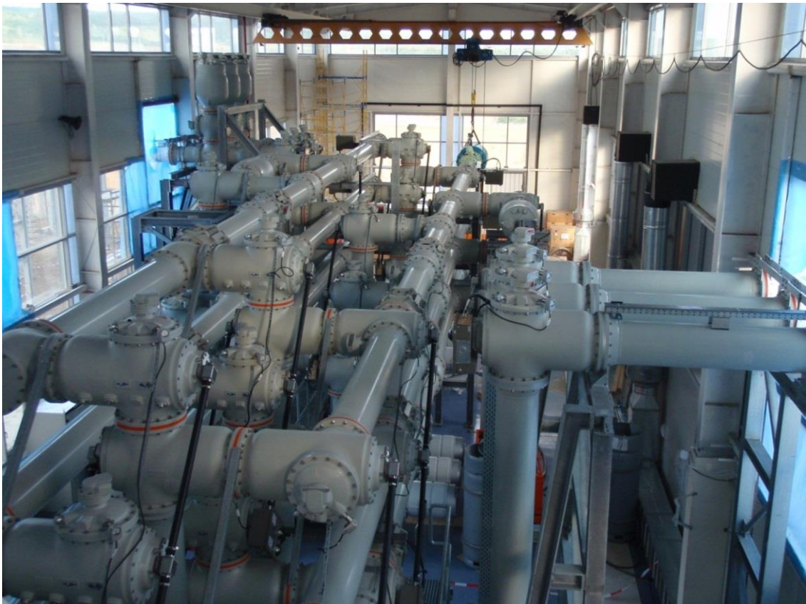
Рисунок 1.1 – КРУЕ-330 кВ Дністровської ГАЕС із элегазовими вимикачами
