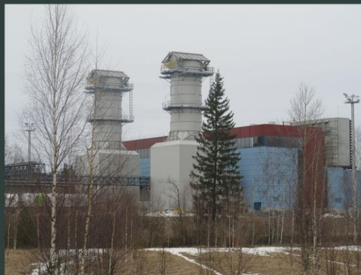
Рисунок 3.1 – Резервна електростанція Fingrid потужністю 300 МВт у місті Форсса з двома газовими турбінами
