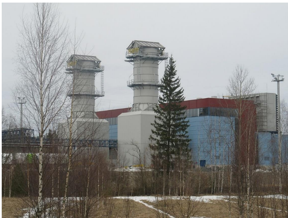
Рисунок 1.5 – Резервна електростанція Fingrid потужністю 300 МВт у місті Форсса з двома газовими турбінами.
