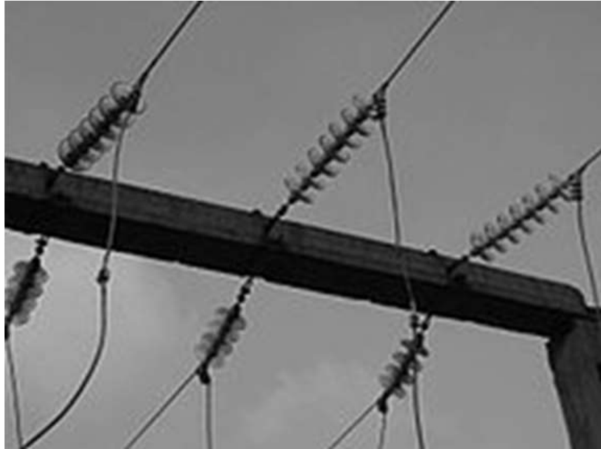
Рисунок 1.3 – Гірлянди підвісних тарілчастих ізоляторів
