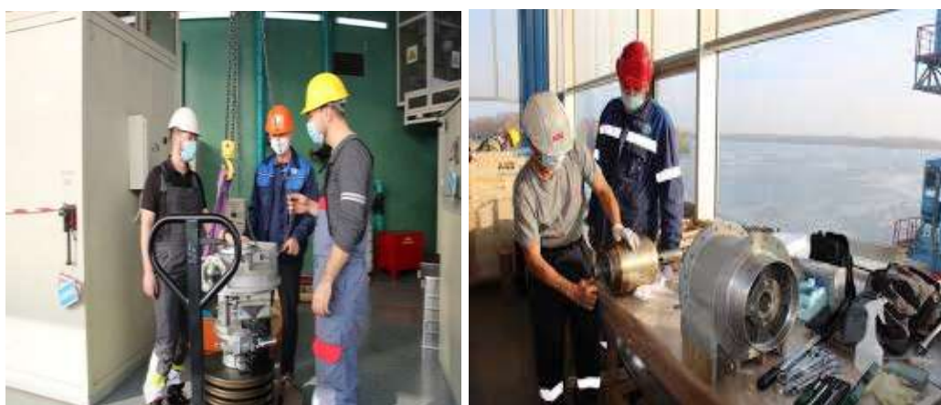
Рисунок 3.7 - Ремонт елегазового високовольтного вимикача
