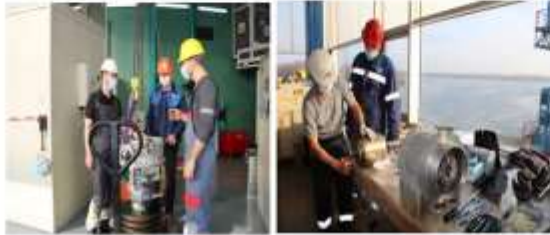
Рисунок 3.3. - Ремонт елегазового високовольтного вимикача
