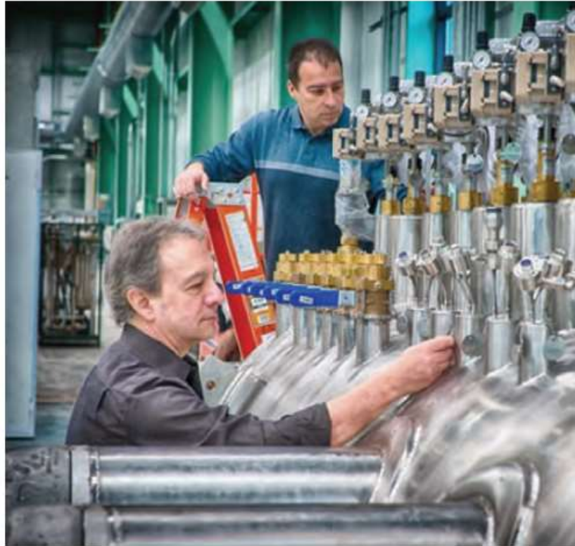
Рисунок 1.3 – Наладка промислового обладнання
