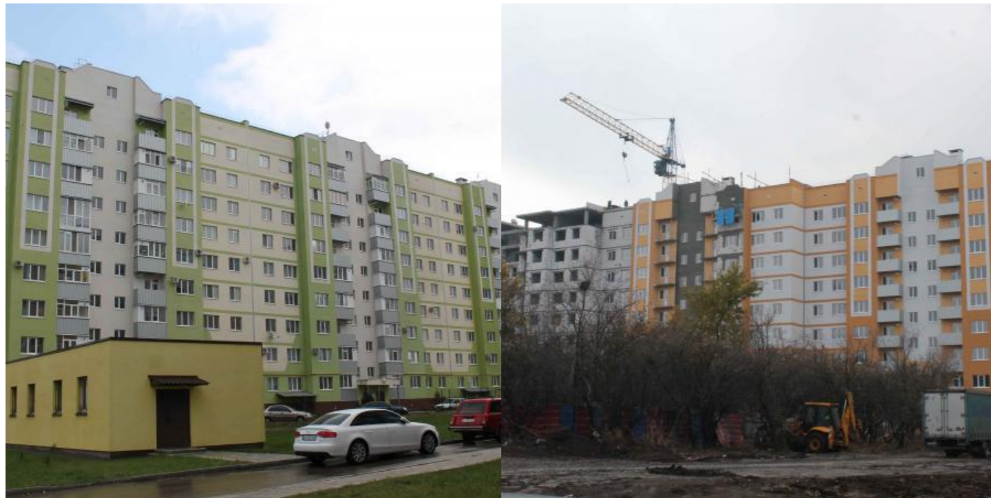
Рис. 1. Житловий комплекс "Садовий" м. Полтава.
