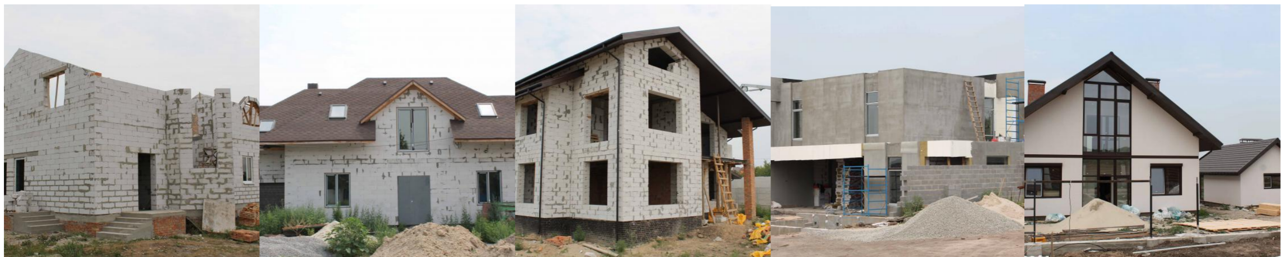
Рис. 3. Котеджне будівництво із використання газоблоків
