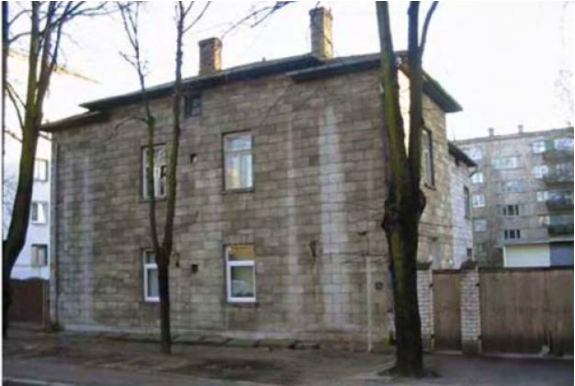
Рисунок 2.1 – Будівля з автоклавного газобетону без зовнішнього оздоблення, 1939 р. побудови, м. Рига, Латвія
