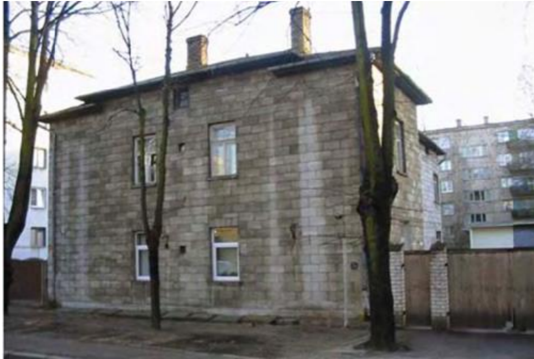
Рис. 4. Будівля з автоклавного газобетону без зовнішнього оздоблення, 1939 р. побудови, м. Рига, Латвія
