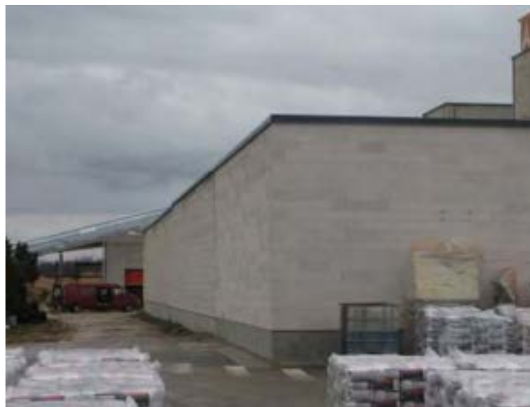
Рисунок 2.4 – Завод по виробництву автоклавного газобетону зі стінами із необробленої кладки
