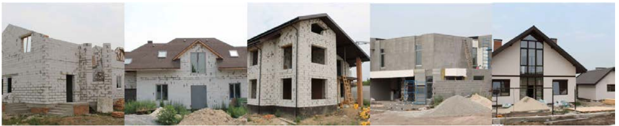
Рисунок 1.4 – Котеджне будівництво із використання газоблоків
