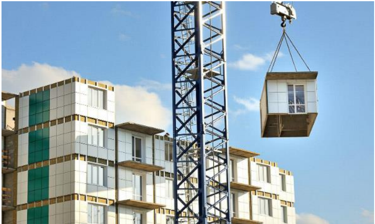
Рисунок 3.1– Блочне спорудження житлових будинків.
