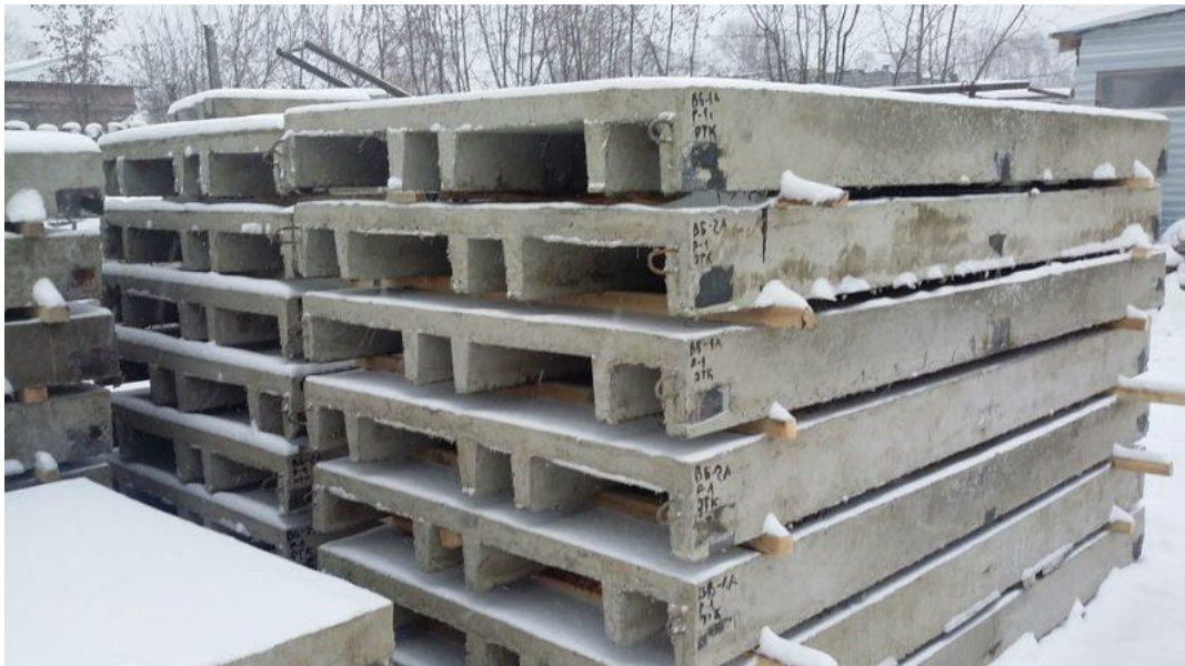
Рисунок 2.2 – Складування вентиляційних блоків.
