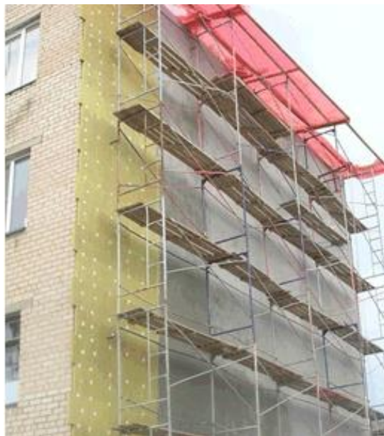
Рисунок 4.3. Утеплення фасаду з будівельних лісів
