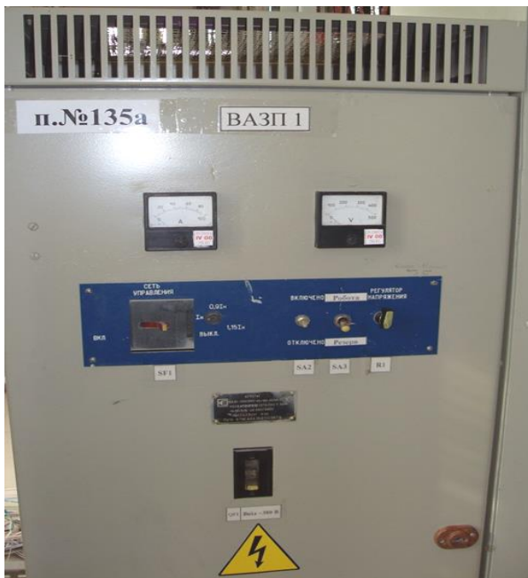
Рисунок 1.4 – Випрямний зарядно-підзарядний агрегат ВАЗП-380/260-40/80
