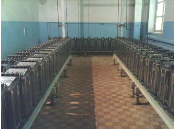
Рисунок 1.2 – Акумуляторна батарея типу СК
