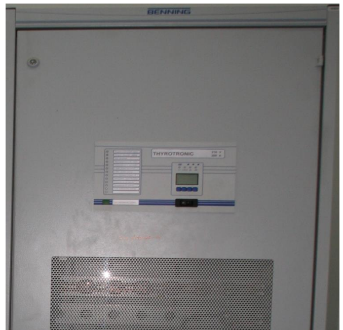
Рисунок 1.5 – Випрямний зарядно-підзарядний агрегат BENNING D400 G216/200
