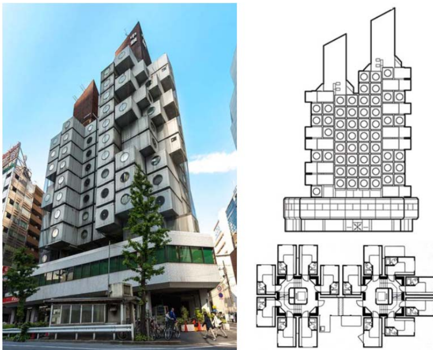
Рисунок 1.1 – Приклад одного із перших трансформативних житлових будинків, Nakagin Capsule Tower (Капсульна башта), Токіо, архітектор К. Курокава (1972 р.)
