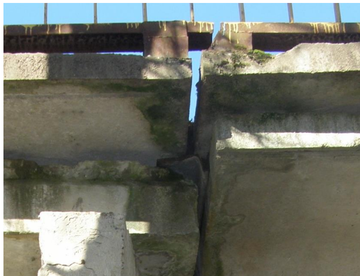
Рисунок 1.8 – Зовнішній вигляд та технічний стан деформаційного шва балочного мосту, збудованого у с. Удич.
