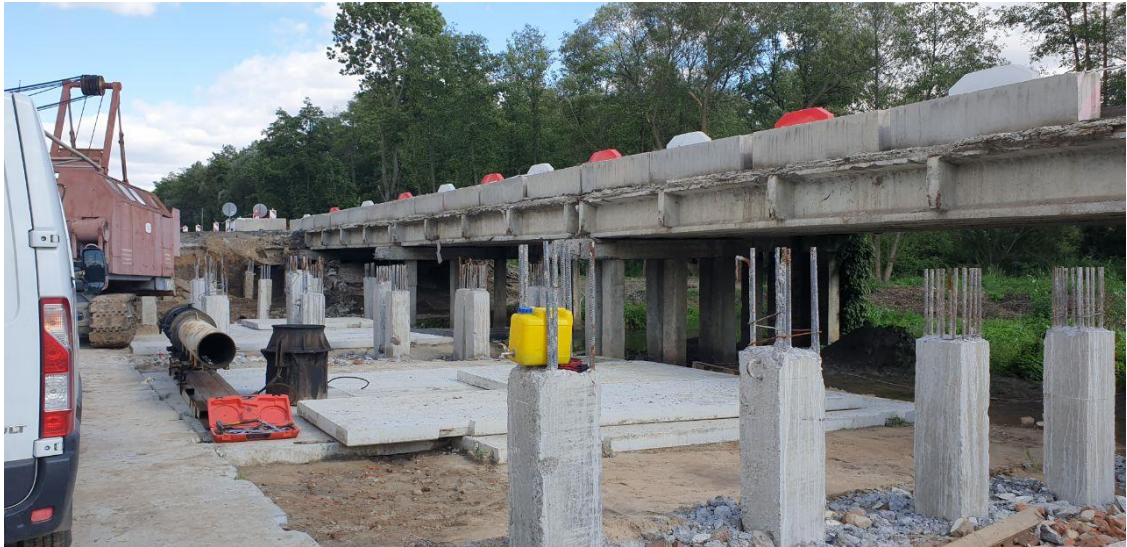
Рисунок 1.2 – Елементи мостової споруди с.Пултівці
