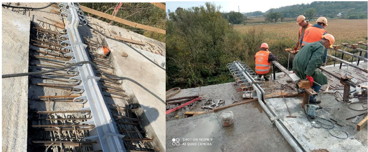
Рисунок 3.13 – Процес укладання деформаційного шва
