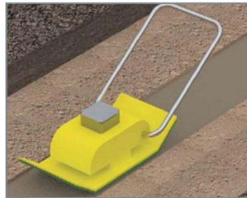
Влаштування корита і ущільнення його основи трамбуванням
