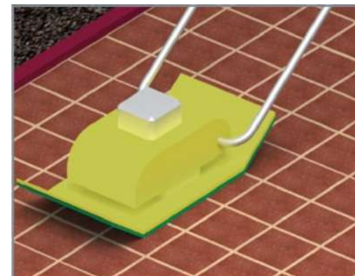
Трамбування тротуарної плитки
