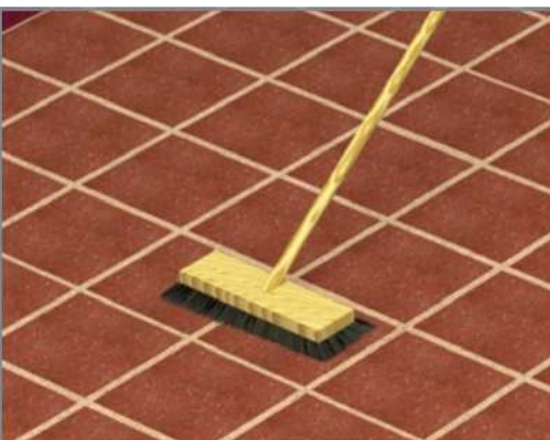
Заповнення швів цементно-піщаним розчином
