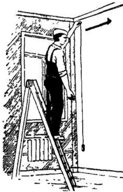
Рисунок 4.3.2 – Провішування стін у кутах
