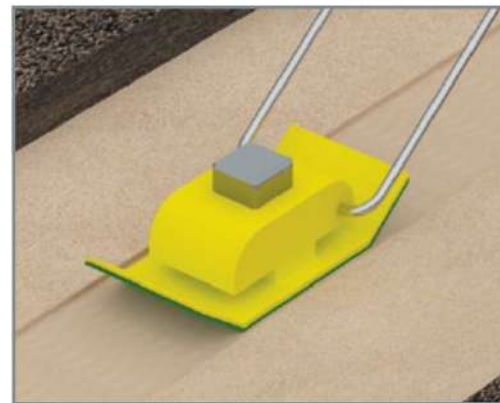
Влаштування піщаної основи і його ущільнення трамбуванням
