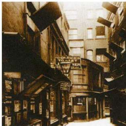
Рисунок 11 – Використання дзеркал для вловлювання денного світла на вузьких вуличках Лондона до Другої світової війни
