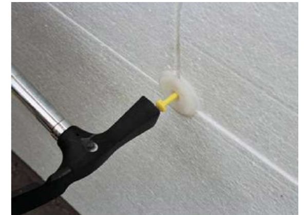
Закріплення плит пінопласту дюбелями
