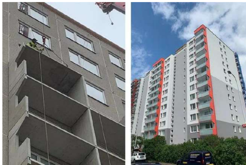
Рисунок 3.1 - Приклад покращення існуючих житлових будинків в Чехії
