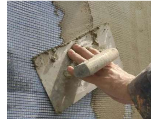
Влаштування армованого склосіткою шару та нанесення клейового розчину
