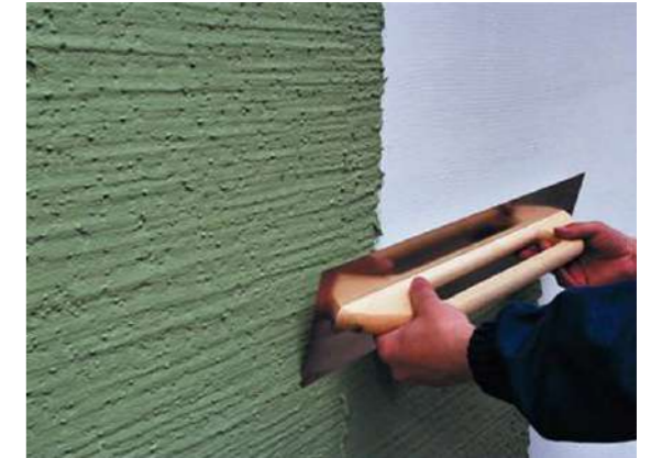
Нанесення декоративної штукатурки
