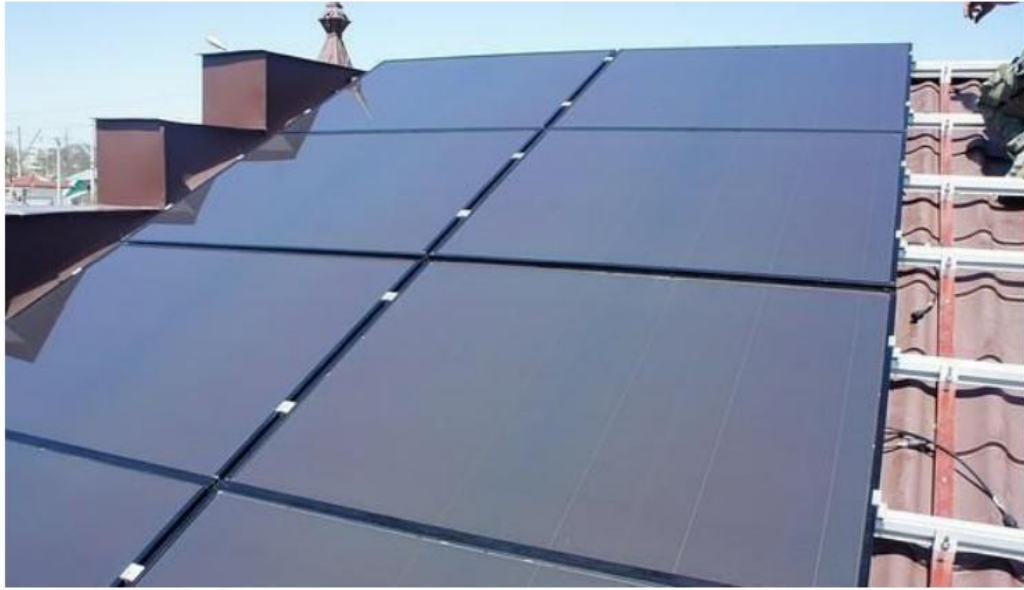
Рисунок 1.7 – Сонячна панель з аморфного кремнію
