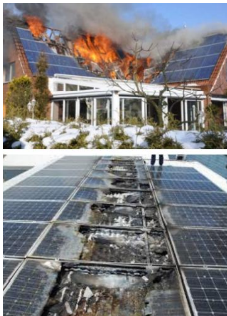
Рисунок В.17 – Аварії, які виникли внаслідок пошкодження ізоляції
