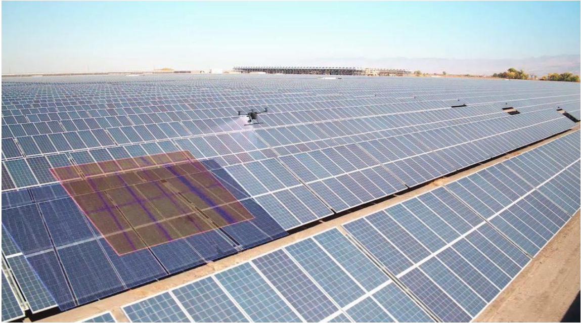
Рисунок 2.5 – Визначення несправностей на ФЕМ за допомогою квадрокоптеру
