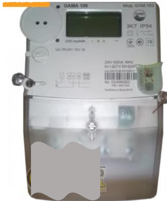
Рисунок 3.7 - Лічильник електроенергії GAMA 100 G1M.153.220.F3.P2.C300.V1
