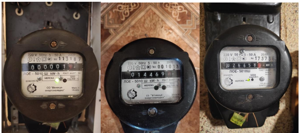
Рисунок 3.14 – Лічильники електроенергії типу ЛОЕ-5010Ш (А 5-50, кл2) виробника АТ «Вінницяобленерго», СО «Вінницяенергоналадка»
