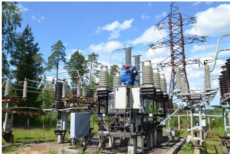
Рисунок 3.10 – Монтаж вакуумного вимикача зовнішнього встановлення типу ВРС-110 на підстанції 110/10 кВ
