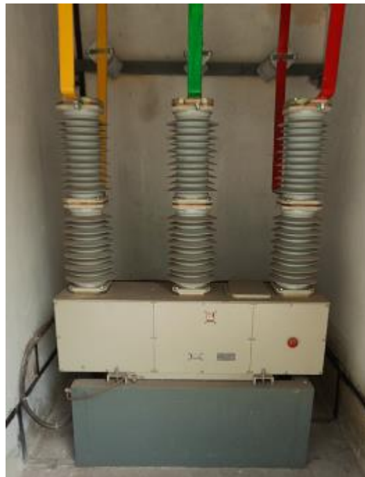
Рисунок 3.8– Вимикач вакуумний зовнішньої установки типу ВБНК-35
