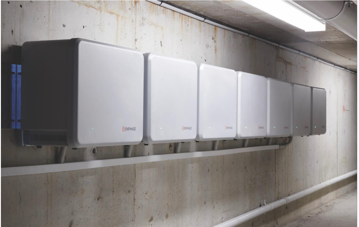
Рисунок 3.12 – Система накоплення енергії AC BATTERY компанії Enphase
