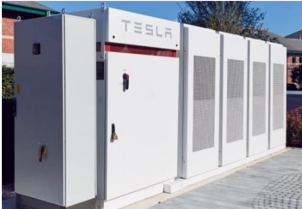
Рисунок 3.7 – Зображення СНЕ Tesla Powerpack
