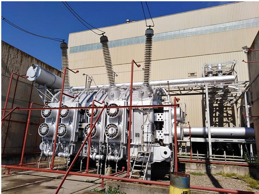
Рисунок 3.8 – Трансформатор ТДЦ-250000/220Т1
