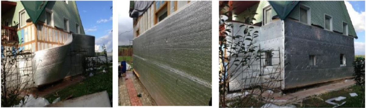
Рисунок 3.6 Утеплення фасаду безшовним матеріалом
