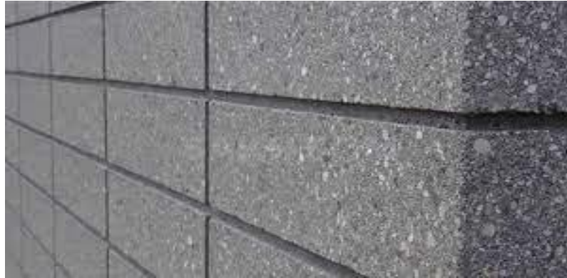
Рисунок 3.1 – Пінополістиролбетонний блок
