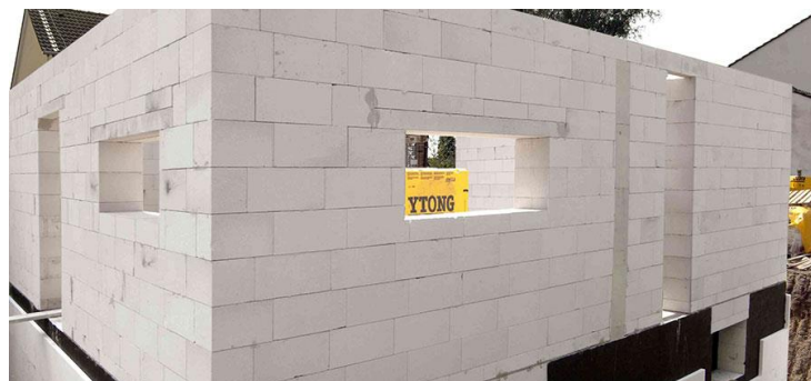
Рисунок 3.2 – Стінова конструкція з газоблоків
