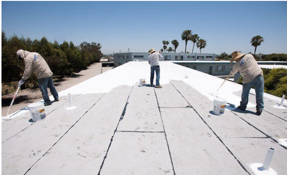
Рисунок 5.1 – Влаштування «холодної покрівлі» - покриття фарбою
