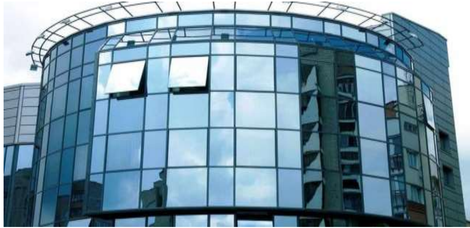
Рисунок 2.2 – Приклад алюмінієвого каркасного фасаду
