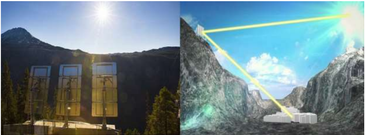
Рисунок 3.10 – Концепція роботи дзеркал
