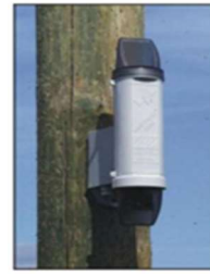
Рисунок 1.12 – Індикатори короткого замикання «LineTroll 111К» (а) та «LineTroll 3100К» (б)
