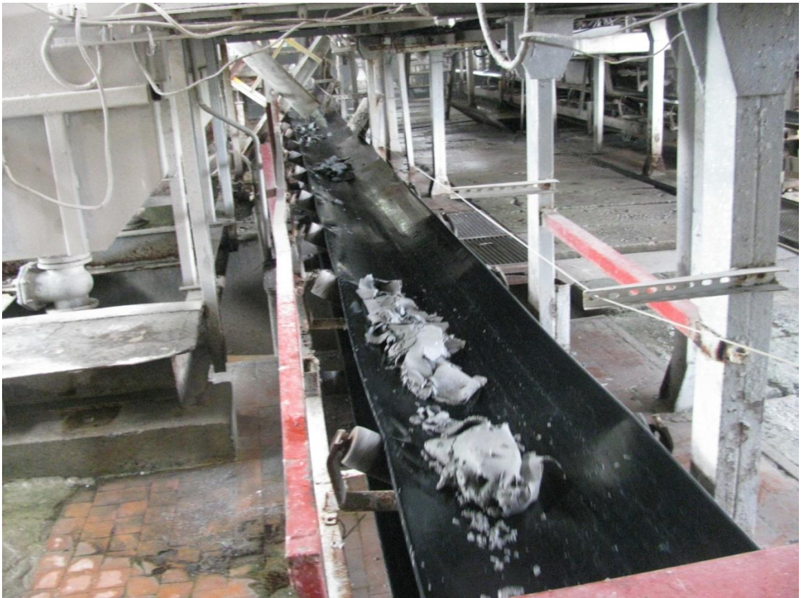
Рисунок 3.11 – Стрічковий фільтр-прес каналізаційних очисних споруд
