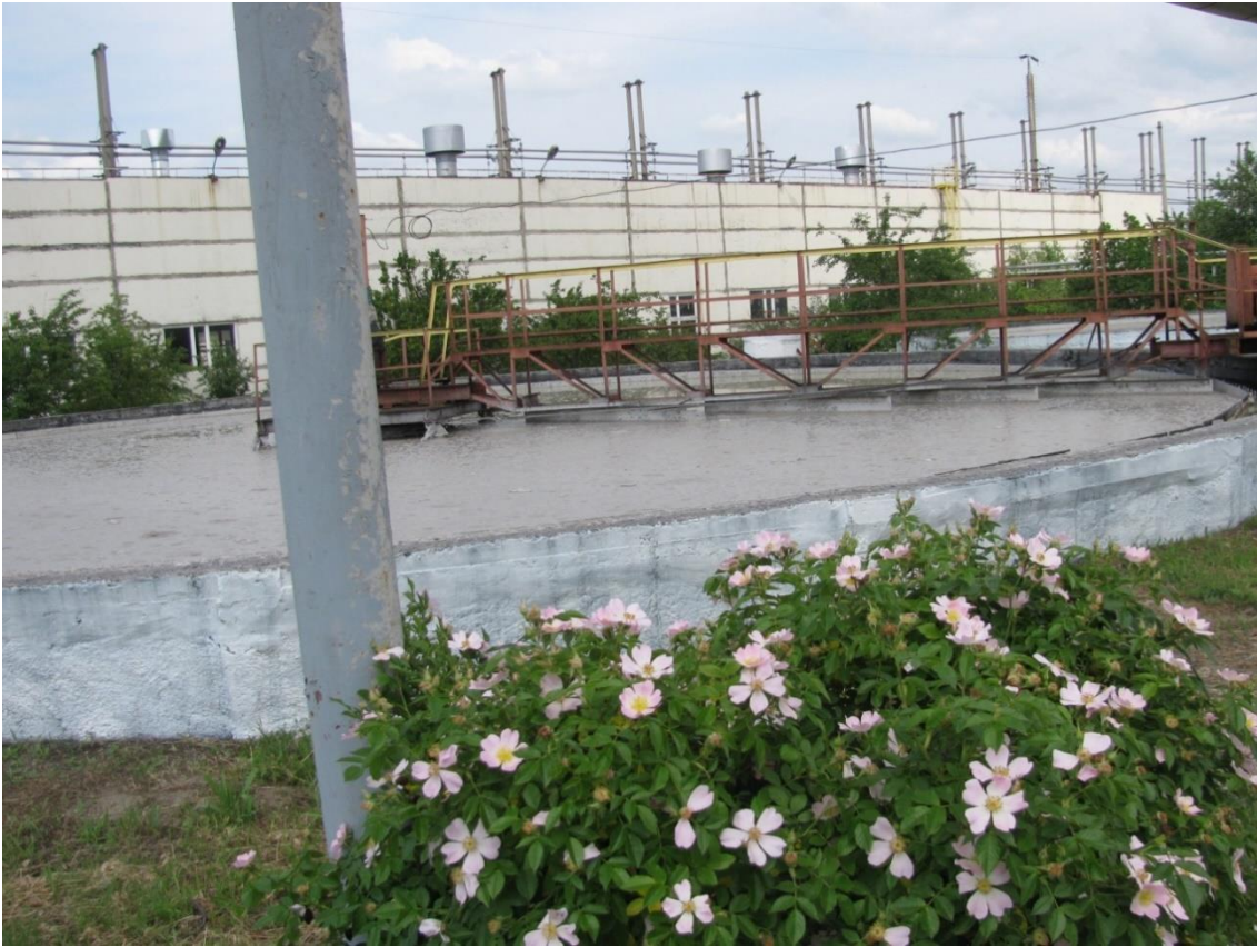
Рисунок 3.2 – Локальні очисні споруди
