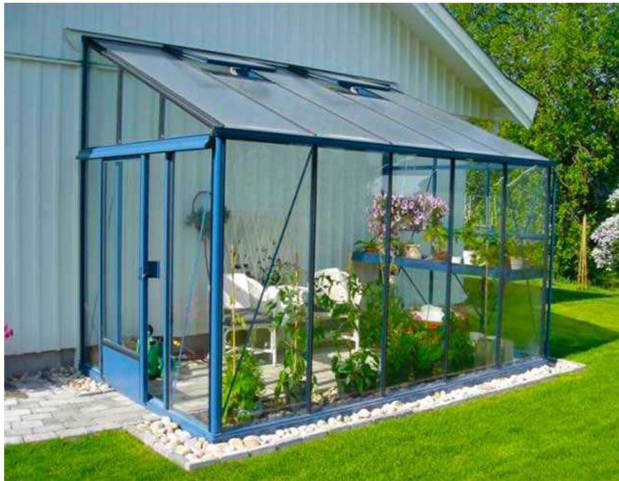
Рис.3 Приклад односхильної теплиці
