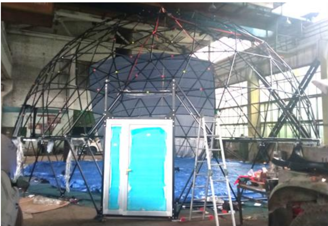
Рисисунок 3.1. - Загальний вигляд каркасу тривимірного проєкційного кінотеатру у вигляді геодезичного куполу фірми ASE Myplanetarium під час виготовлення. Тентове покриття змонтоване частково.
