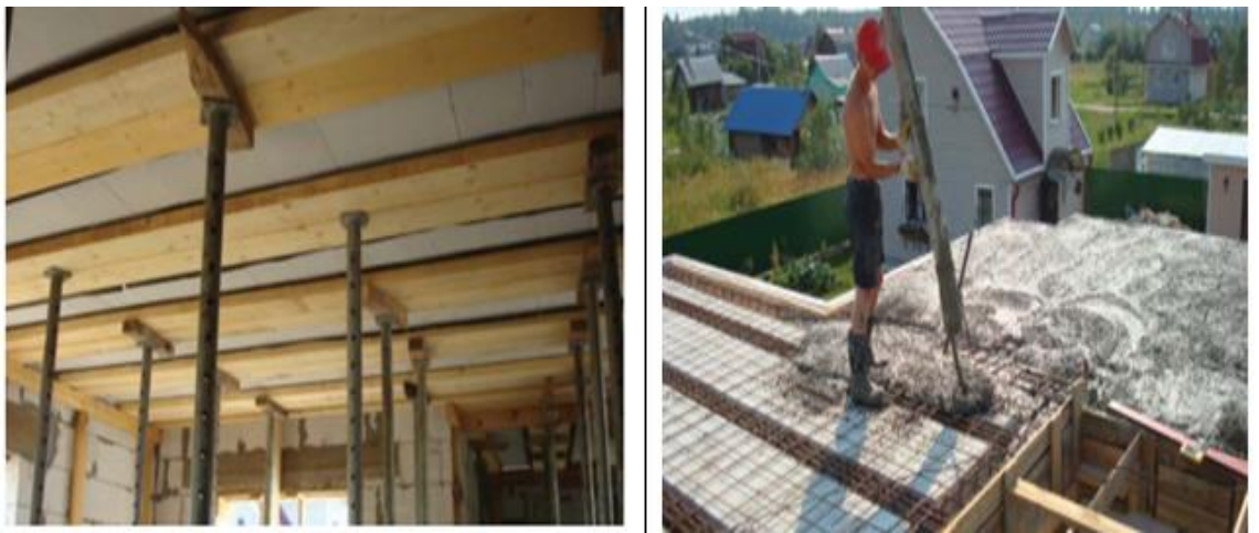
Рис 4.12. Технологічні процеси влаштування збірно монолітного перекриття.
