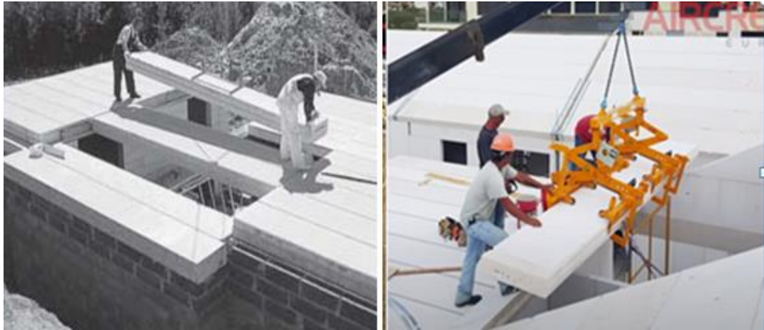
Рис. 4.9. Фрагмент монтажу газобетонних плит перекриття.
