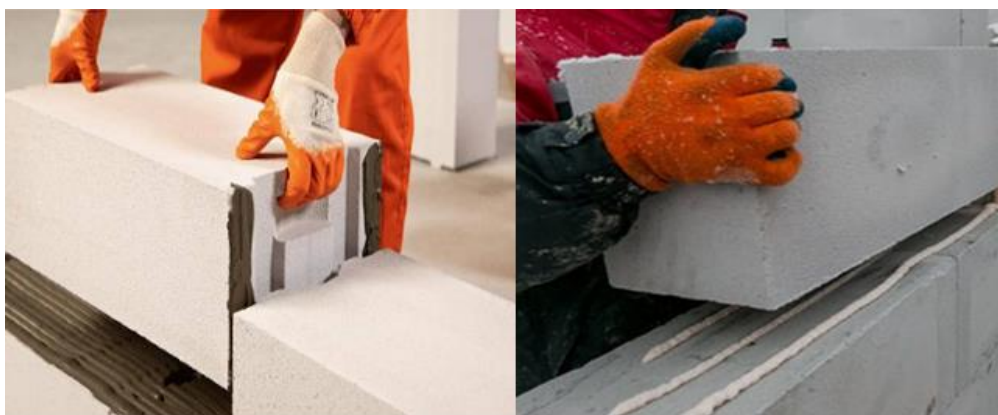
Рис. 4.3. Приклад кладки стіни з допомогою мінерального та ППУ-клею.
