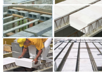
Газобетонні та пористі бетонні блоки укладаються на балки
