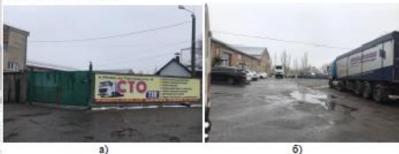
Рисунок 1.1 – Загальний вигляд виробничо-технічної бази станції технічного обслуговування автосервісу ТОВ «СВ ВІН АГРО СЕРВІС»
