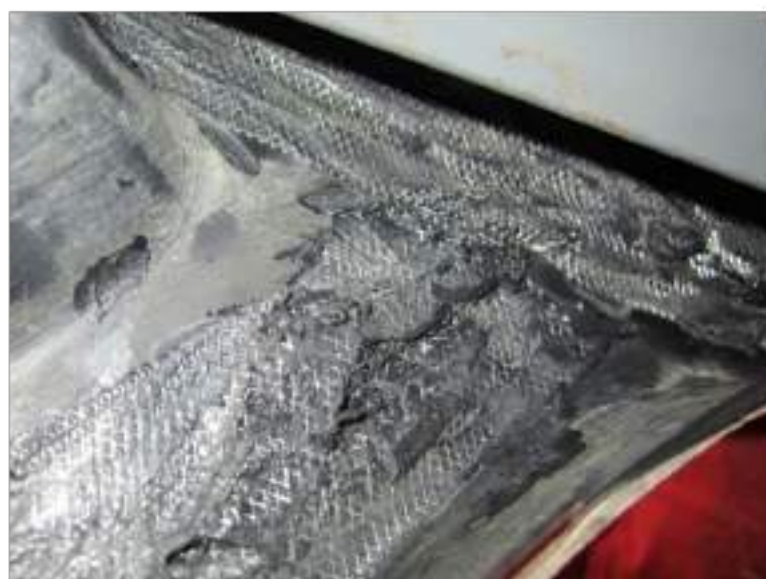
Рисунок 1.12 – Відновлення деталей з армуванням
