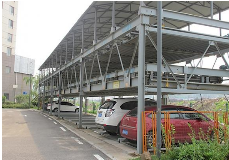
Рисунок 1.3 — Механізовані багатоярусні паркувальні системи
